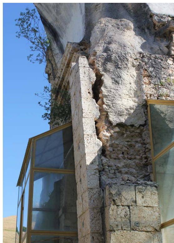
Figg. 5a-5b. Cascia, S. Maria della Neve (particolari). Sono evidenti le precarie condizioni in cui versa l'apparecchio murario della chiesa (foto D'Avino 2024).
