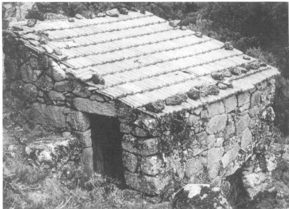
Fig. 20 et 21. Vue de l'extérieur et de l'intérieur d'un petit moulin à eau qui fait partie de l'ensemble de Soutobom, situé dans la commune de Tondela. Couples de meules de petites dimensions, présentant la tournante, dans ce cas, un trou sur la face supérieure où l'on introduisait un bâton qui permettait de la mouvoir manuellement.
