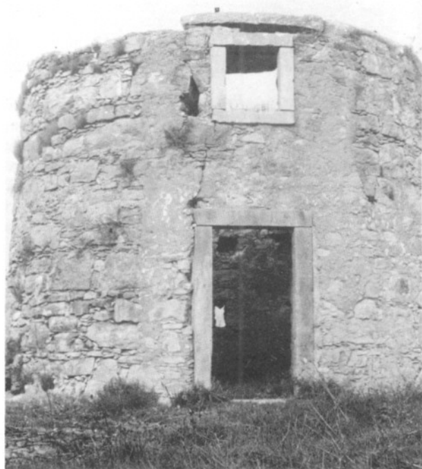
Fig. 15 et 16. Moulin en ruine existant près de Eiras, commune de Coimbra, qui a eu autrefois le système de traction au moyen d'une poulie intérieure et la toiture reculée. Dans la photo inférieure, on peut voir un détail de l'arc en pierres appareillées, liées autrefois les unes aux autres par de grands crampons et qui terminait supérieurement la paroi circulaire. L'entaille où roulaient les petites roues de la sablière tournante de l'engin se situait très près de la face interne de la paroi circulaire, ce qui montre que la toiture de ce moulin était reculée, les entailles radiales, visibles elles aussi, servant à l'écoulement de l'eau de pluie.
