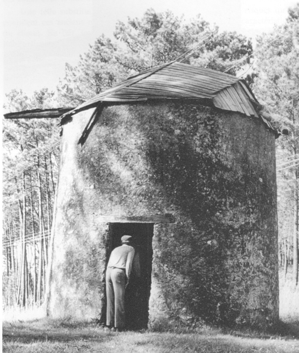
Fig. 8 et 9. Type de moulin courant dans la région de la commune de Mortágua, dans lequel l'orientation au vent est faite par la rotation d'une grille sur une sablière en bois. La toiture est à huit pans, s'adaptant parfaitement soit à une construction circulaire soit au système de traction utilisé.
