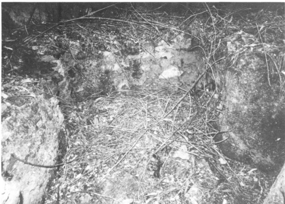
Fig. 10. Intérieur ruiné d'un moulin, situé dans la commune de Mortágua, qui présente un système de contreforts non imbriqués dans la paroi circulaire et qui servaient d'appui aux poutres et au plancher. Dans ce cas, le rez-de-chaussée n'était pas utilisé comme logement d'une bête de somme.
