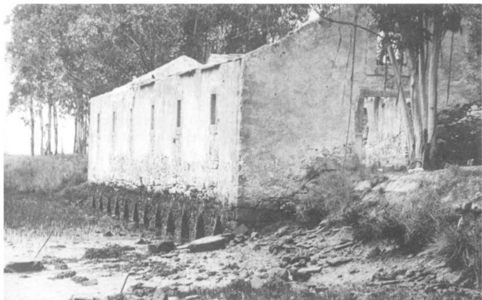
Fig. 3. Ruines d'un ancien moulin à marée, autrefois avec douze couples de meules, et qui se situe à l'embouchure de la rivière Pranto, un affluent de la rive gauche du fleuve Mondego. Il est actuellement l'objet d'un programme de conversion en musée.
