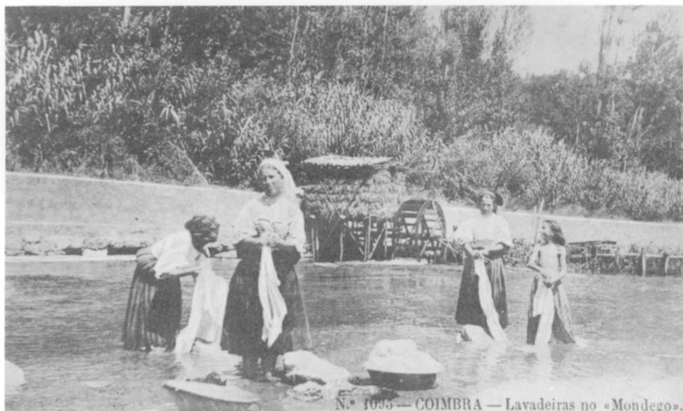
Fig. 19. Moulin à eau temporaire, à roue verticale en dessous, installé autrefois sur le fleuve Mondego pendant la période estivale. Ce type d'engin se substituait à ceux qui, se situant dans des petites rivières, ne pouvaient pas travailler pendant cette période par manque d'énergie. Un tel système alternatif, qui supposait un travail d'installation pénible, était cependant utilisé à la place du moulin à vent, soit parce qu'il procurait une économie de parcours soit à cause des difficultés subies par la monture éolique après une politique forestière mal conduite et qui a modifié les régimes de vents de la région.
