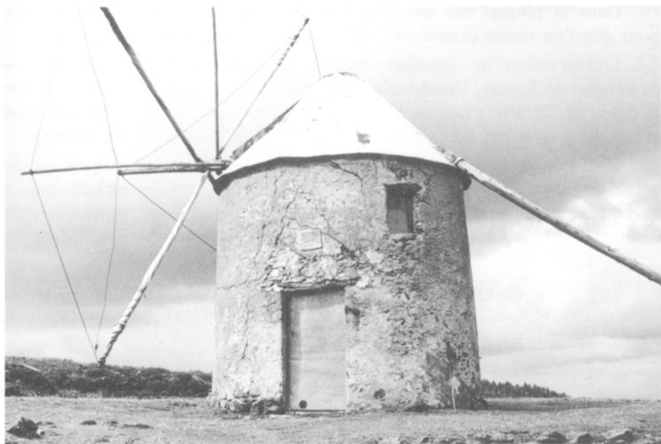
Fig. 5. Moulin-tour en pierre et toiture tournant sur une grille au moyen d'une queue que l'on pousse.
