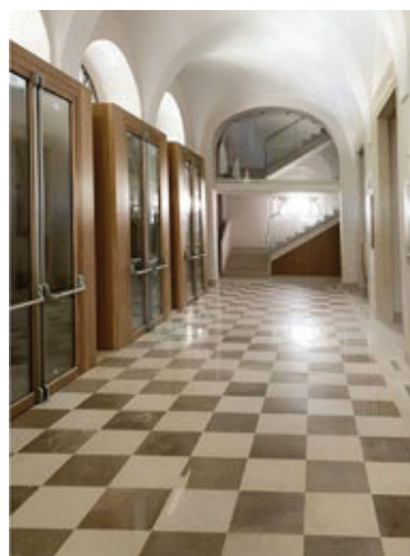
Fig. 14 Immagine dell'atrio di ingresso in direzione della scala dx.
