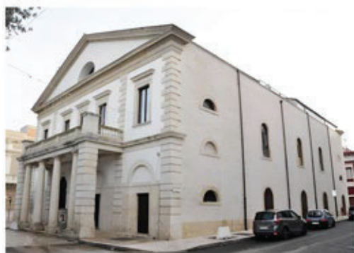
Fig. 21 Scorcio della facciata e del fianco dx nelle ultime fasi del restauro.
