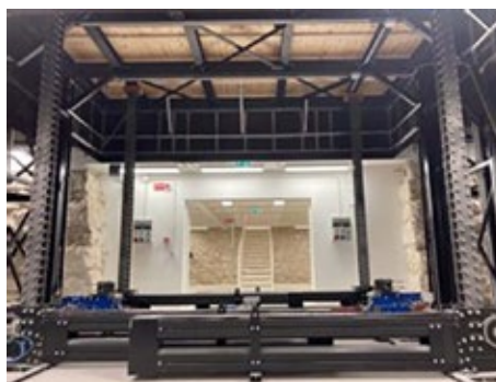
Fig. 10 Immagine della piattaforma centrale motorizzata (vista al piano sottostante la platea).
