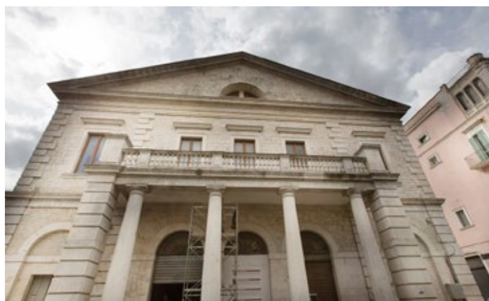
Fig. 4 Immagine della facciata come appariva nel 2004 e prima dell'odierno restauro.
