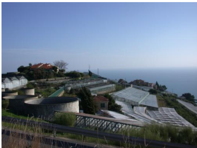
Fig. 3.17 - L'impatto delle serre diventa negativo se cancella la traccia dei terrazzamenti, come accade per quaele a destra e sinistra dell'immagine. Le serre al centro sono certamente più accettabili.
