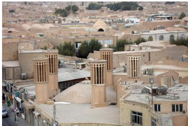
Fig. 3.12 - Le "torri del vento" di Yazd (Iran) sono tra le attrattive del sito più pubblicizzate.
