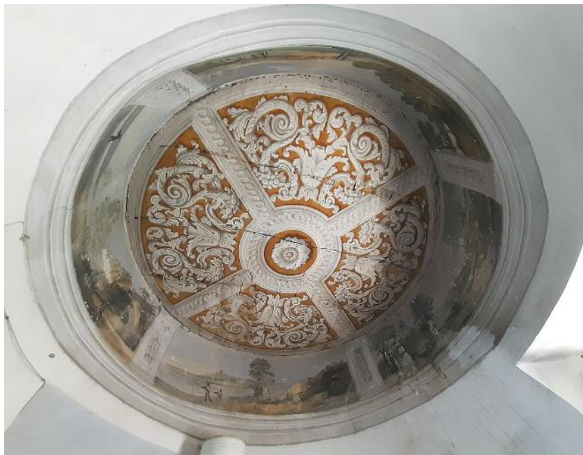
Fig. 12. Decorazione seicentesca nel vano interno alla torre circolare nell'appartamento al piano terreno.
