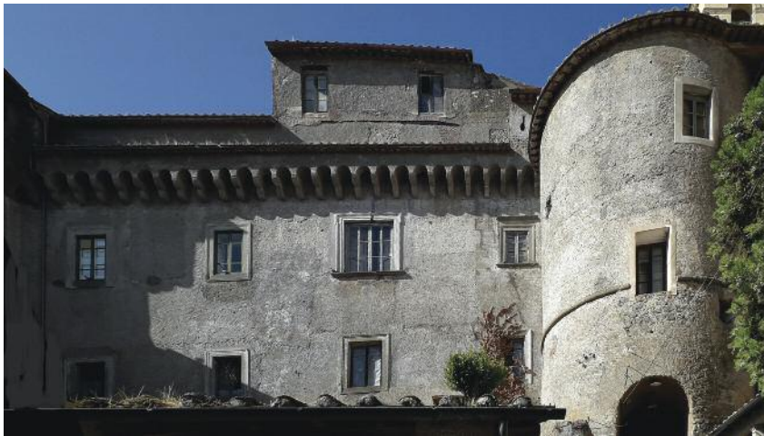
Fig. 6. Fronte verso la valle.
