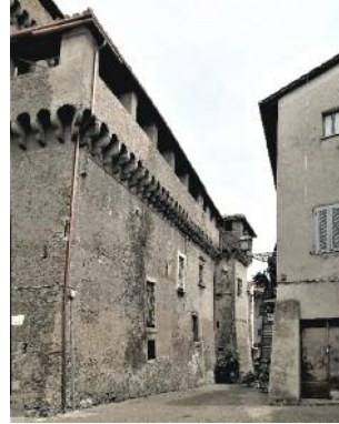
Fig. 4. Fronte su piazza del Comune.
