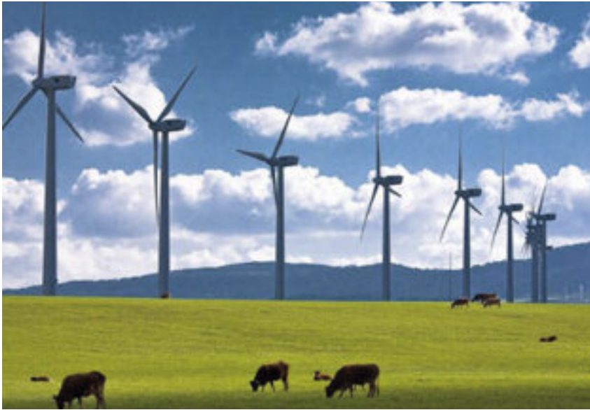
Campi eolici: San Gavino, Cagliari.
