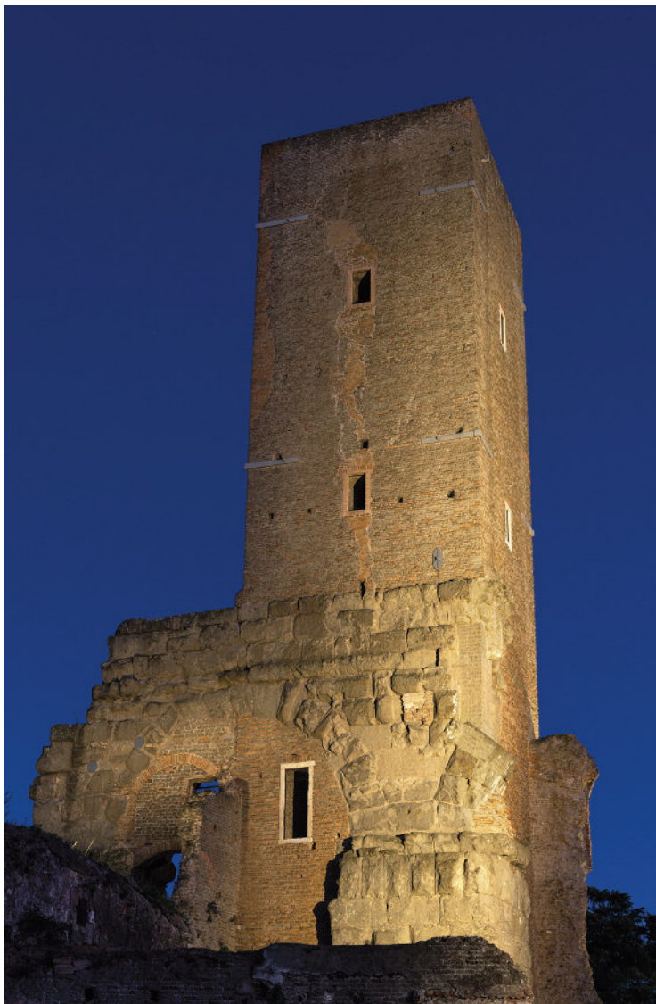
Fig. 15 La Torre del Fiscale nel quartiere omonimo all'interno della quale è l'incrocio degli acquedotti, dopo i recenti restauri.
