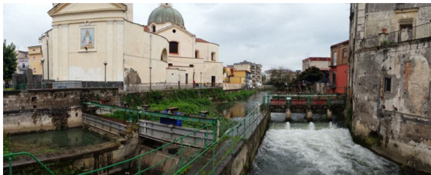
Fig. 2 Traversa di Scafati.
