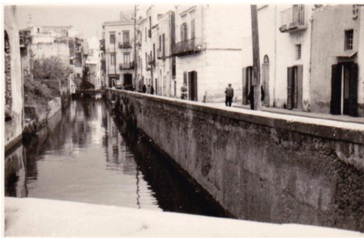
Fig. 1 Via Zara, Scafati.
