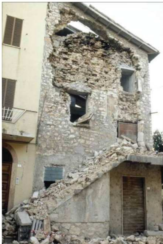
Fig. 10 L'effetto dei "rafforzamenti" conseguiti attraverso l'introduzione dei diaframmi rigidi prescritti dalle norme tecniche per le costruzioni in zona sismica: i solai originari in legno seguivano le deformazioni della scatola muraria, quelli in c.a., infinitamente rigidi nel loro piano, generano spinte dall'interno verso l'esterno. E il muro appare "spellato".
