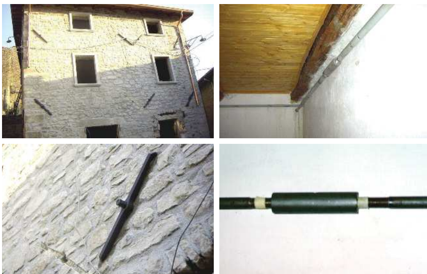
Fig. 13 Collegamento tra le murature d'angolo e i solai con catene in ferro diametro 28mm con paletti e manicotto di raccordo (1999).
