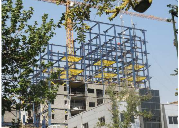
Fig 1. Tehran nord, palazzo in costruzione (aprile 2017). Dopo il terremoto di Bam del 26 dicembre 2003 (M Richter 6.6), che fece fra 20000 e 30000 vittime, si preferisce intelaiare d'acciaio anche nell'edificio corrente.
