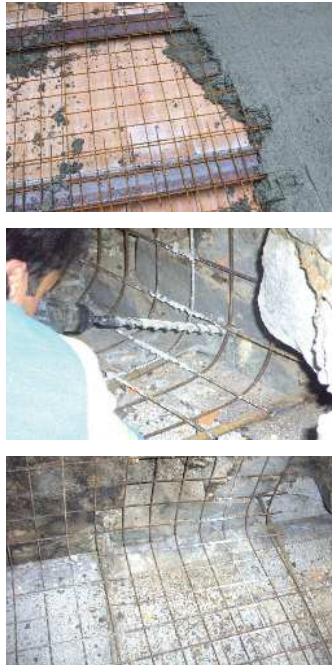
Fig. 21 Realizzazione di irrigidimento di un solaio in putrelle e collegamento alle murature (1999).
