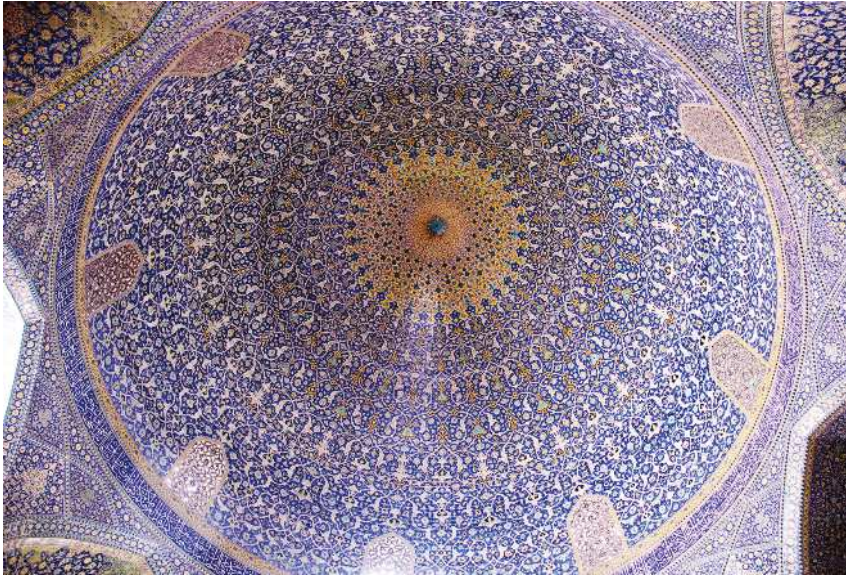
Fig. 9. Isfahan, Moschea Reale, soffitto della cupola interna. L'adozione della doppia cupola, assai frequente in area islamica, può fungere da smorzatore delle vibrazioni sismiche. Qui il soffitto della cupola interna raggiunge un'altezza di 36,3 m. mentre quello superiore arriva a 51 m. Sono state registrate 49 diverse intensità di eco, di cui 12 percepibili dall'orecchio umano.
