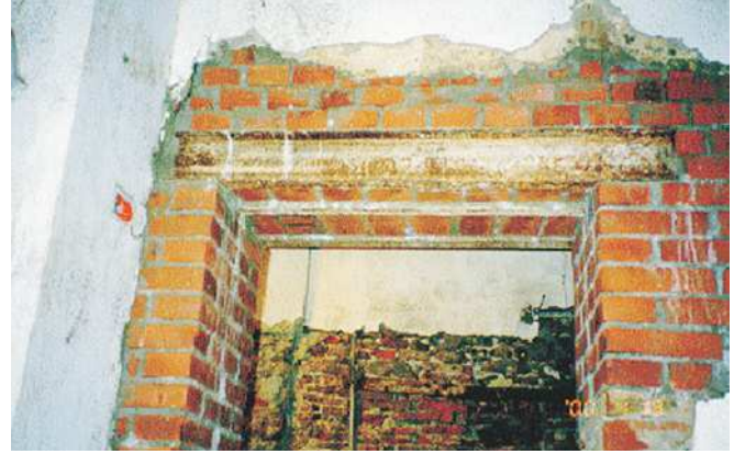
Fig. 12 Nel caso di architravi di porte o finestre, la riparazione e/o sostituzione sarà in funzione della tipologia costruttiva: piattabanda in putrelle o arco ribassato (1999).
