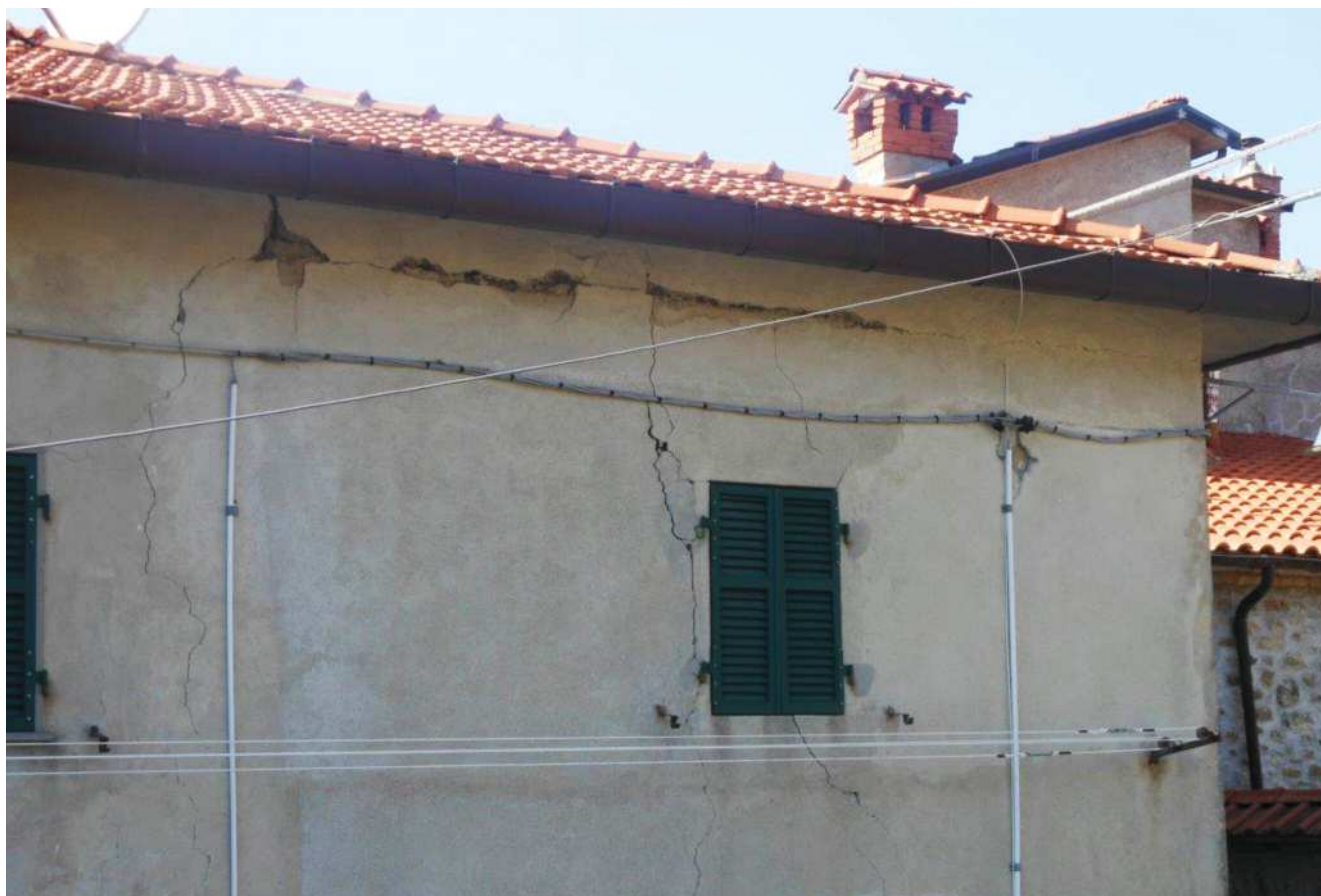
Fig. 28 Casola in Lunigiana, edificio con rifacimento della copertura eseguito nel 1985 con criteri sismici e dichiarato inagibile.
