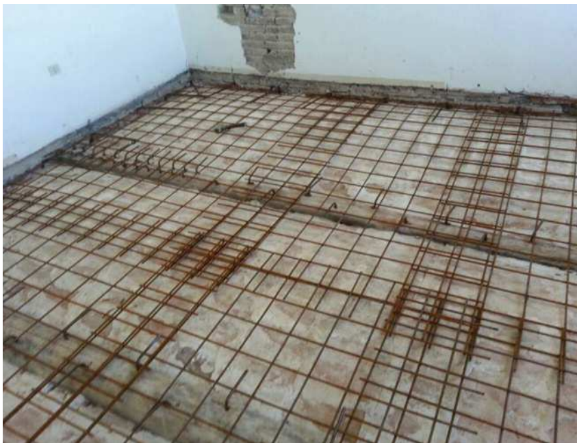
Fig. 9 Possibile intervento di irrigidimento degli impalcati con connessione alle pareti perimetrali.
