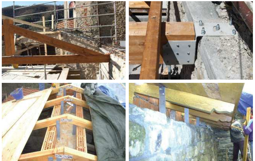
Fig. 19 Realizzazione di nuovi tetto in legno e collegamento alle murature (1999).
