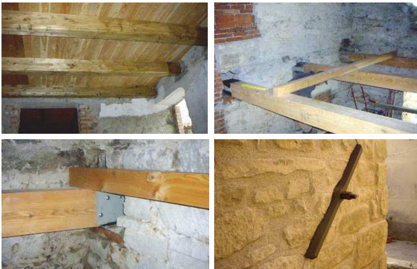
Fig. 18 Realizzazione di un nuovo solaio in legno e collegamento alle murature (1999).
