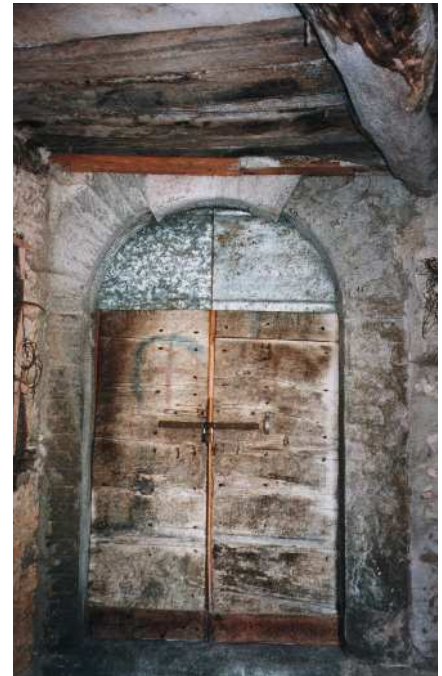
Fig. 10 Chiave scivolata, Castelletto (fraz. di Giuncugnano LU).
