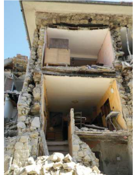
Fig. 8 Evidenza della separazione del paramento interno ed esterno delle pareti.
