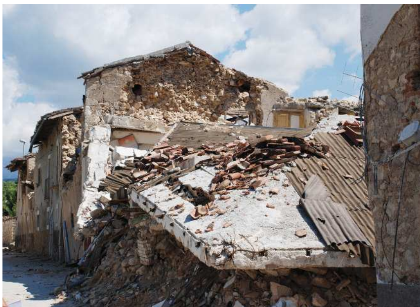
Fig. 4 In ossequio alla normativa sismica gli originari tetti e solai in legno sono stati sostituiti con strutture rigide, in c.a. Le nuove strutture hanno resistito egregiamente al terremoto (L'Aquila 2009, Onna), peccato che i sottostanti edifici siano andati completamente distrutti.
