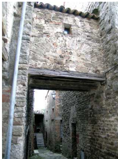
Fig. 13 (a sinistra) Corpi di contrasto, Monterchi (AR).
