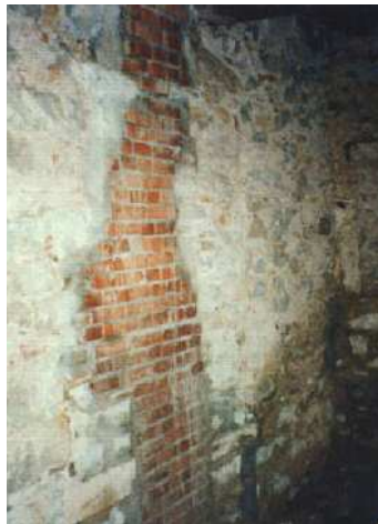
Fig. 16 Ricostruzione della muratura con mattoni e collegamenti con barre acciaio inghisate con malta cementizia (1999).
