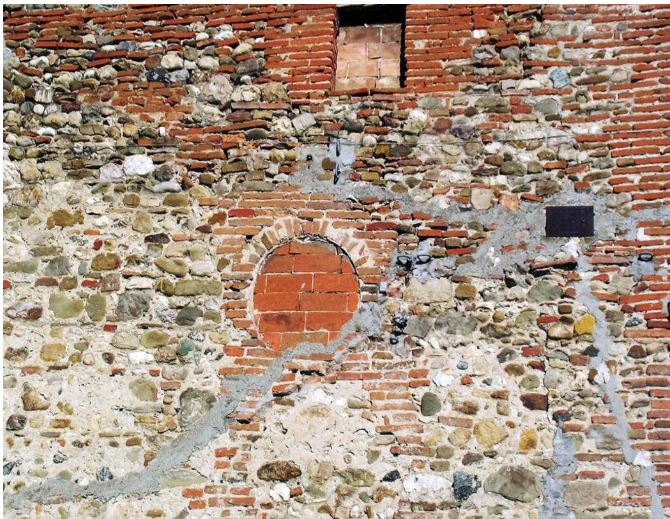
Fig. 15 Muratura disomogenea, Anghiari (AR).
