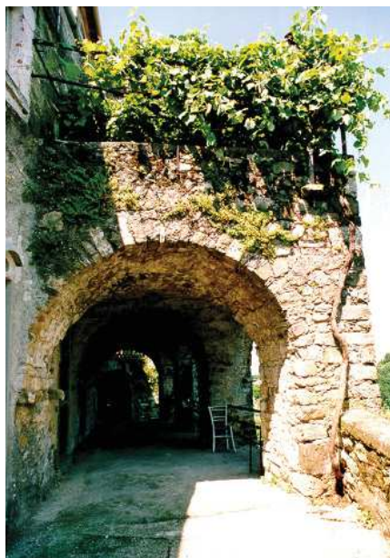
Fig. 9 Terrazzo aia, Viano (fraz. di Fivizzano MS).
