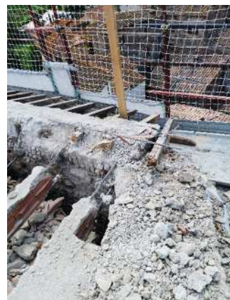
Fig. 17 Demolizioni di copertura in latero cemento (1999).
