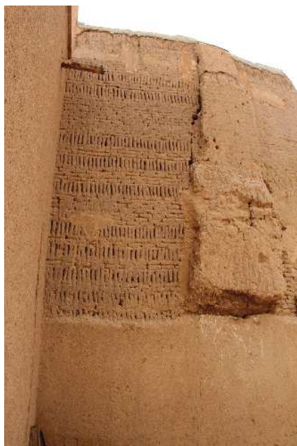
Fig. 2. Kashan (Iran), resti di vecchio manufatto in mattoni crudi e intonaco di paglia e fango. Il mattone crudo di paglia e fango è tuttora in uso: ha meno resistenza al carico ma è più duttile, perché non si frattura. Probabilmente ha anche maggiore capacità di dissipazione.
