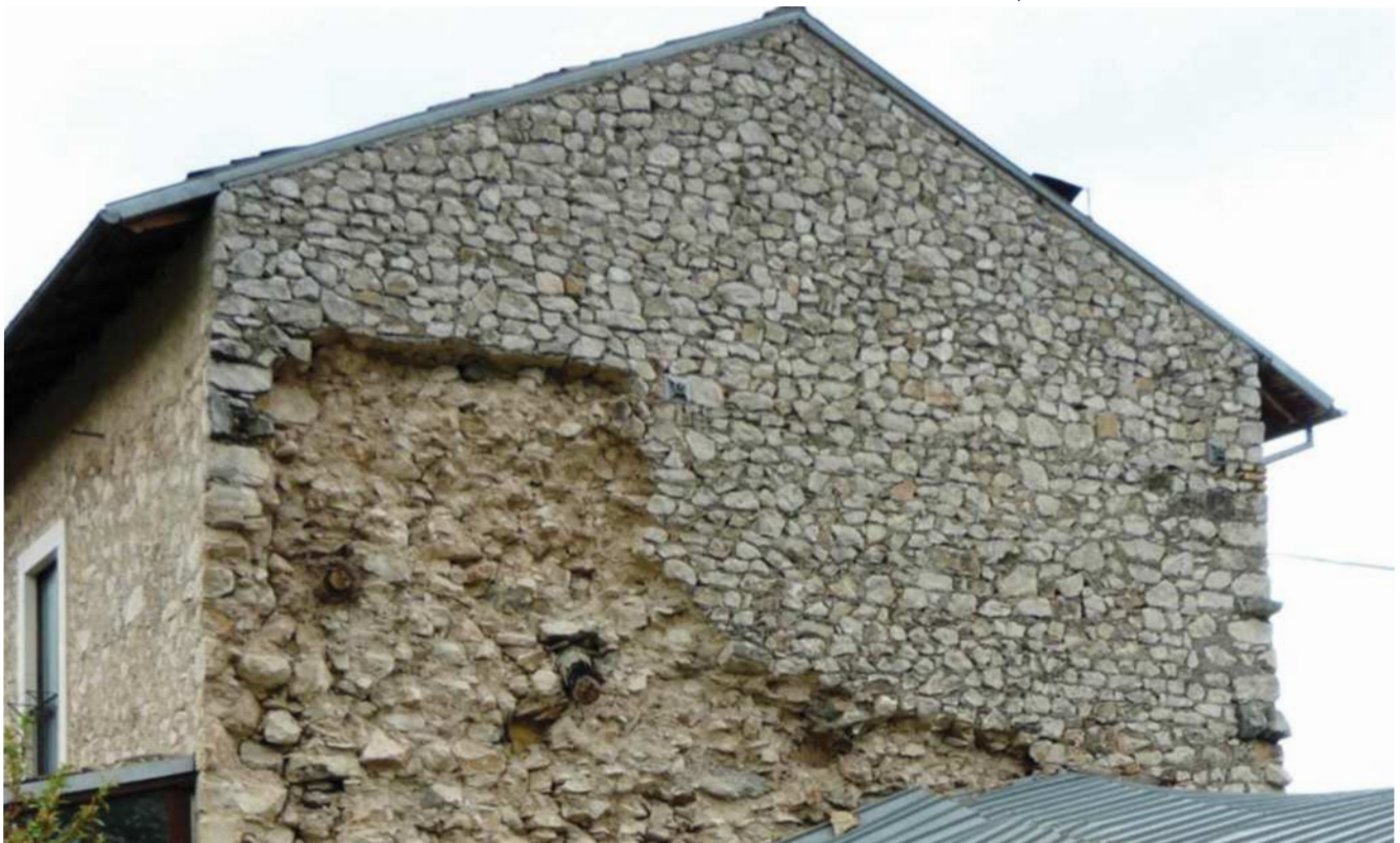
Fig. 8 Evidenza della separazione del paramento interno ed esterno delle pareti.
