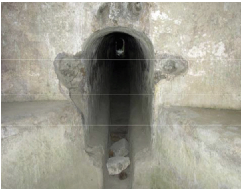
Fig.6 Lo speco del canale Conte di Sarno percorribile da una persona in piedi quasi sempre in tutto il suo sviluppo sotterraneo.
