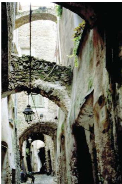
Fig. 5 Gli archi in primo piano hanno una evidente funzione statica. Ma il passaggio voltato in fondo è stato realizzato per stabilizzare le due facciate o per ampliare le abitazioni che si affacciavano sulla strada?
