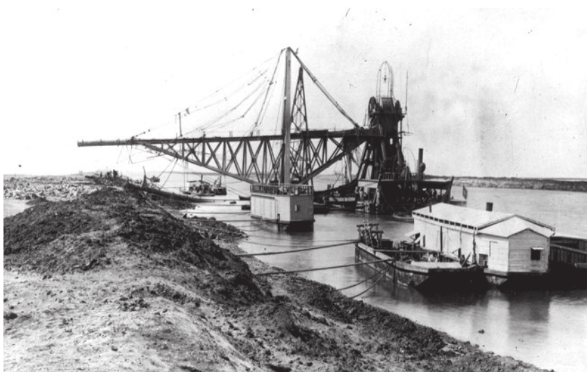
Fig. 3 Canale di Suez: I lavori di scavo con le draghe all'oper (Credits: Getty Images).
