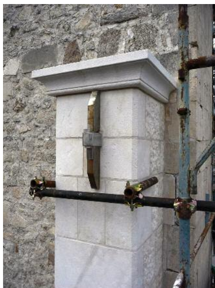
Fig. 11-12-13-14 L'Aquila, Chiesa di San Silvestro, Dettagli intervento di restauro.
