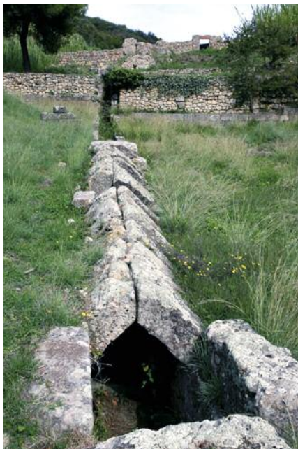
Fig. 16 Vallone del Frittolo. Canale.
