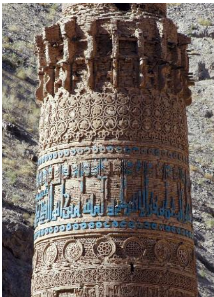
Fig. 7 Jâm, Afghanistan. Élément du décor du minaret, entre 28 et 31 m., en caractères coufiques de 3 m. de hauteur, briques glaçurées de couleur bleu turquoise (bleu au cuivre Cu^{2+} ): dédicace au sultan Ghiyâth al-din . Pour les temps modernes, c'est l'un des usages les plus anciens de céramique glaçurée en architecture (ph. Max Schvoerer, 03/09/2003).
