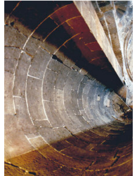
Fig. 9 Chiesa di S. Hripsimè, rinforzo semicilindrico interno.
