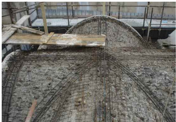
Fig. 2 Chiesa di S. Giovanni del Toro in Ravello. Realizzazione del manto di copertura della volta a crociera con la tecnica del battuto (fonte Tiziano Ferrigno)
