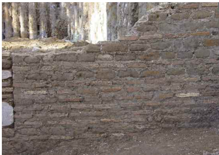
Fig. 6 Particolare delle cortine murarie (archivio S.S.B.A.R.)
