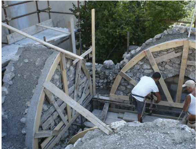
Fig. 1 Chiesa di S. Giovanni del Toro in Ravello. Realizzazione dei due archi della cupola con la tecnica della centina (fonte Tiziano Ferrigno)
