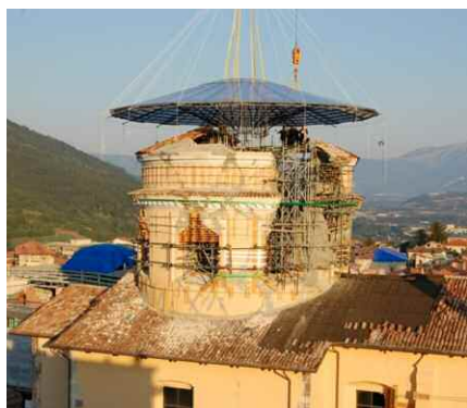
Chiesa delle Anime Sante messa in opera copertura del Ragno
