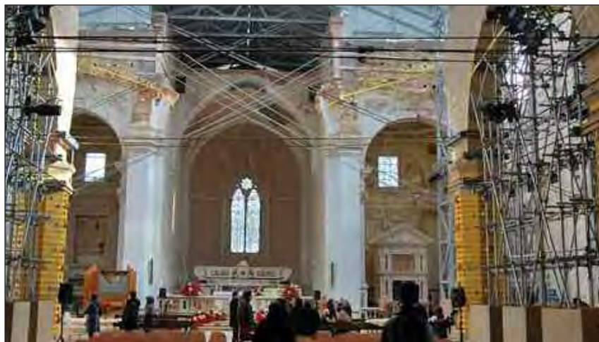
Basilica di Collemaggio, opere provvisorie, transetto
