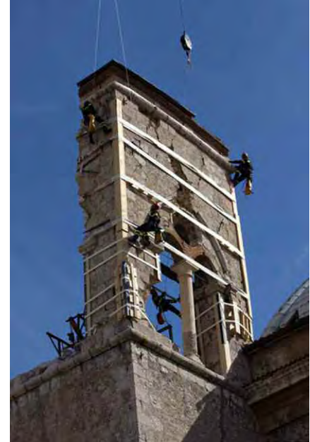
L'Aquila, Basilica di San Bernardino, particolare del campanile
