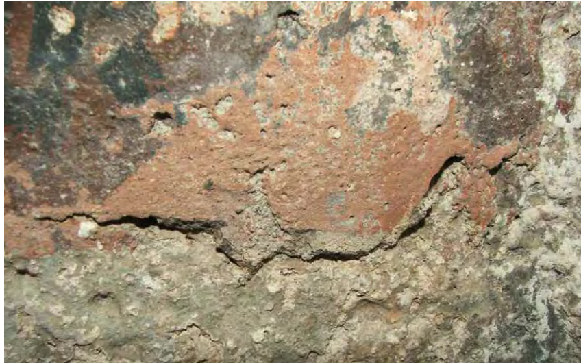
Fig. 2: Distacco dell'intonaco (part.).
