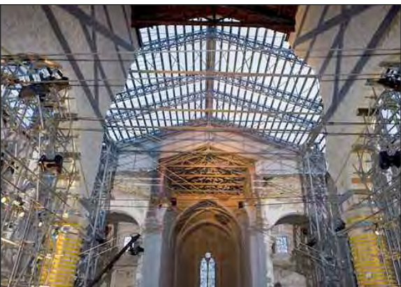
Basilica di Collemaggio, opere provvisorie, navata centrale
