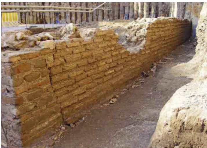
Fig. 5 Particolare delle cortine murarie (archivio S.S.B.A.R.)
