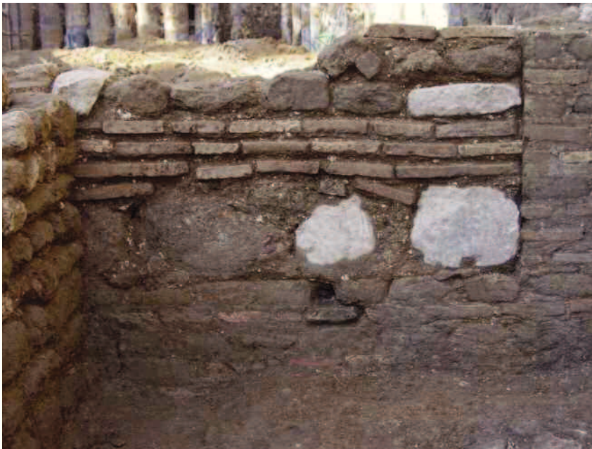
Fig. 7 Tamponatura sul lato sud dell'edificio (archivio S.S.B.A.R.)
