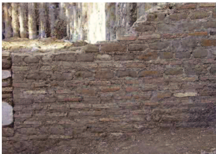
Fig. 6 Particolare delle cortine murarie (archivio S.S.B.A.R.)
