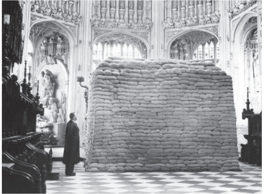
Fig. 5 1940, Londra (Gran Bretagna), Abbazia di Westminster, Lady chapel di Enrico VII: protezione (Seconda Guerra Mondiale, foto Keystone).
