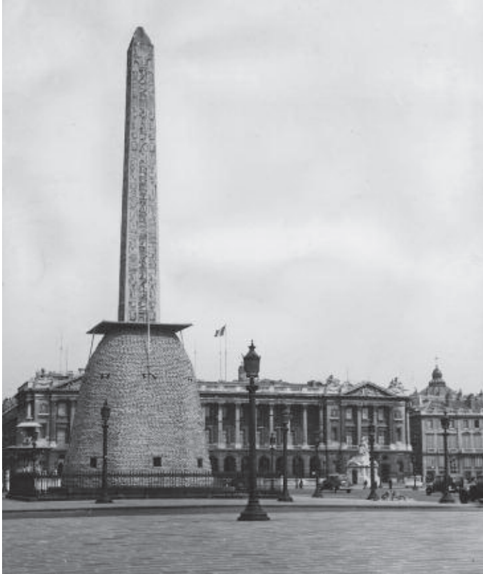
Fig. 7 1940, Parigi (Francia), Obelisco Place de la Concorde: protezione (Seconda Guerra Mondiale, foto George W. Hales).
