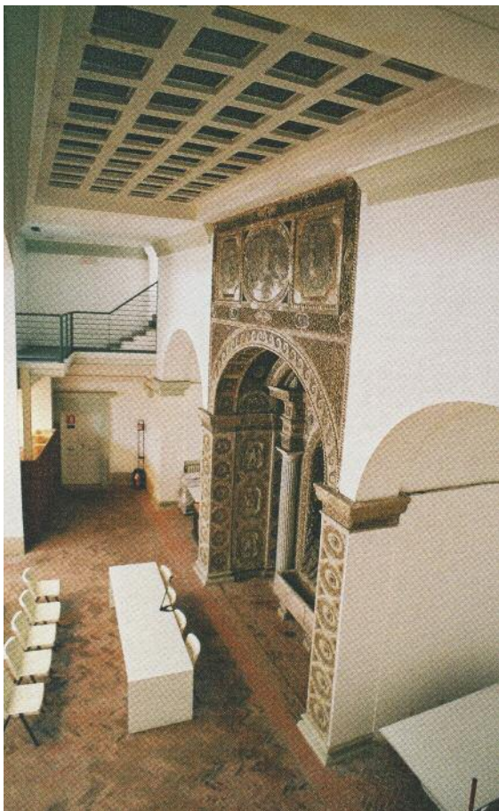
Fig. 18 La copertura in vetrocemento del 1934, sostituita nel 2006 con i lavori che hanno determinato l'aspetto attuale del museo (da Campitelli, Arconti 2006, p. 117).
