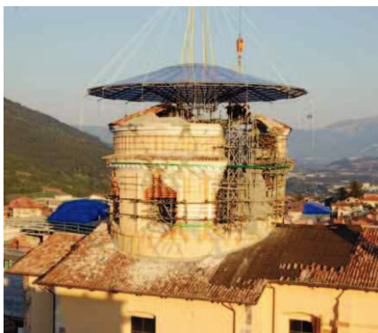
Chiesa delle Anime Sante messa in opera copertura del Ragnò
