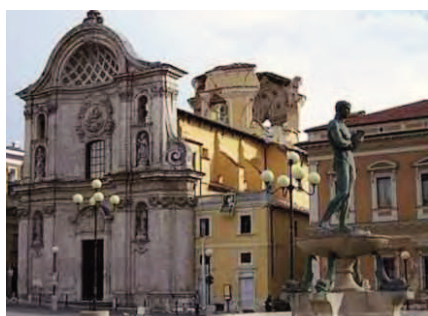
L'Aquila, Chiesa delle Anime Sante, dopo il sisma del 2009
