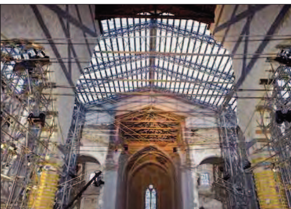
Basilica di Collemaggio, opere provvisorie, navata centrale
