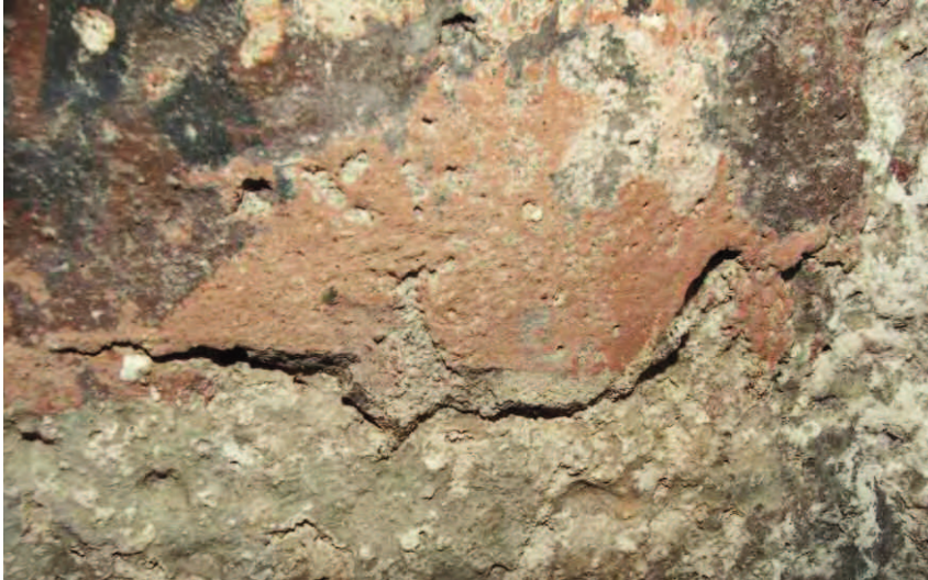
Fig. 2: Distacco dell'intonaco (part.).
