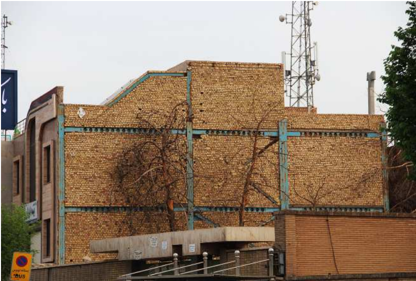
Fig. 3. Yazd (Iran). Esempio di impiego del mattone di paglia e fango come parete di tamponamento, all'interno di un telaio d'acciaio.
