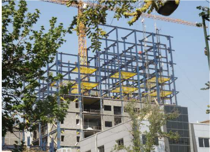
Fig 1. Tehran nord, palazzo in costruzione (aprile 2017). Dopo il terremoto di Bam del 26 dicembre 2003 (M Richter 6.6), che fece fra 20000 e 30000 vittime, si preferisce intelaiare d'acciaio anche nell'edificio corrente.
