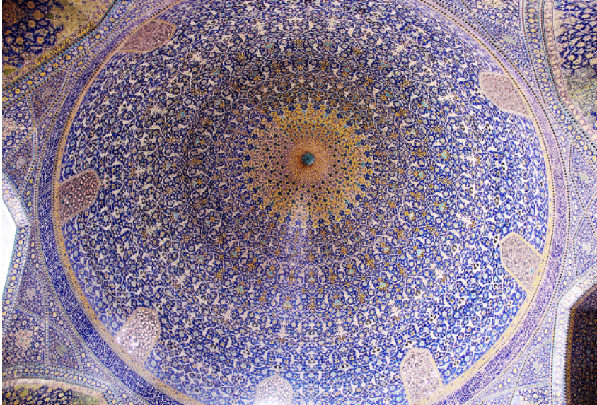
Fig. 9. Isfahan, Moschea Reale, soffitto della cupola interna. L'adozione della doppia cupola, assai frequente in area islamica, può fungere da smorzatore delle vibrazioni sismiche. Qui il soffitto della cupola interna raggiunge un'altezza di 36,3 m. mentre quello superiore arriva a 51 m. Sono state registrate 49 diverse intensità di eco, di cui 12 percepibili dall'orecchio umano.
