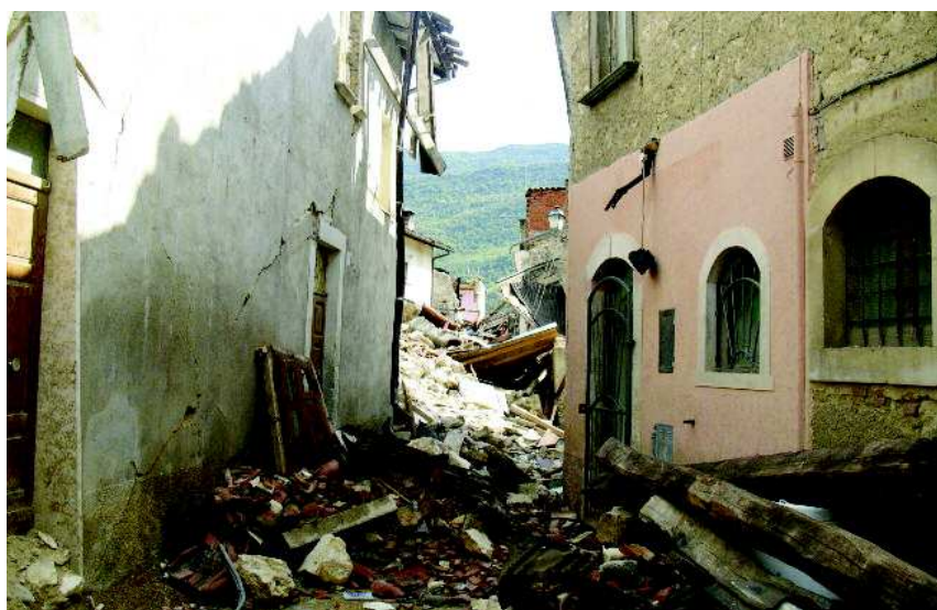
Fig. 14 Esempio di problematiche sulla viabilità per il raggiungimento dei cantieri per l'esecuzione delle messe in sicurezza.
