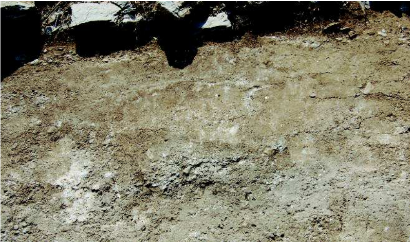
Fig. 8 Alès, oppidum de l'Ermitage. Serrage du mortier du rudus: on lit nettement le geste du mosaïste qui a fait « suer » (sécher) le mortier d'un large mouvement de taloche (cliché V. Blanc-Bijon, AMU – CNRS, CCJ, Aix-en-Provence).
