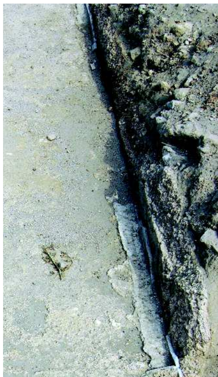
Fig. 11 Arles, site de la Verrerie, support de la mosaïque de l'Aiôn. Le long des parois, la mise en place des placages pariétaux est intervenue après celle du support de la mosaïque, puis un raccord de mortier gris est venu combler l'espace avant la pose des tesselles (cliché V. Blanc-Bijon, AMU – CNRS, CCJ, Aix-en-Provence).
