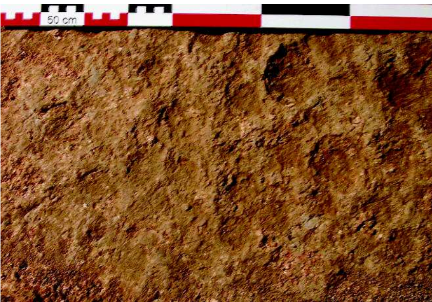
Fig. 9 Vaison-la-Romaine (Vaucluse, France), rue Fabre. En surface du rudus, les cupules résultent du traitement effectué par le mosaïste qui a tassé le mortier avec un pilon en bois (cliché ACRM/MDAA).
