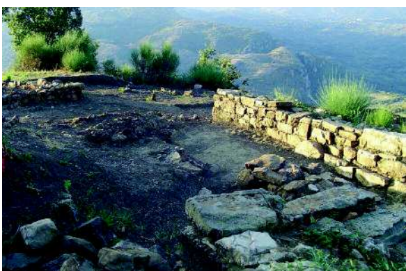
Figg. 16-18. Roscigno, Monte Pruno. Particolare del versante S/O e S/E delle fortificazioni.
