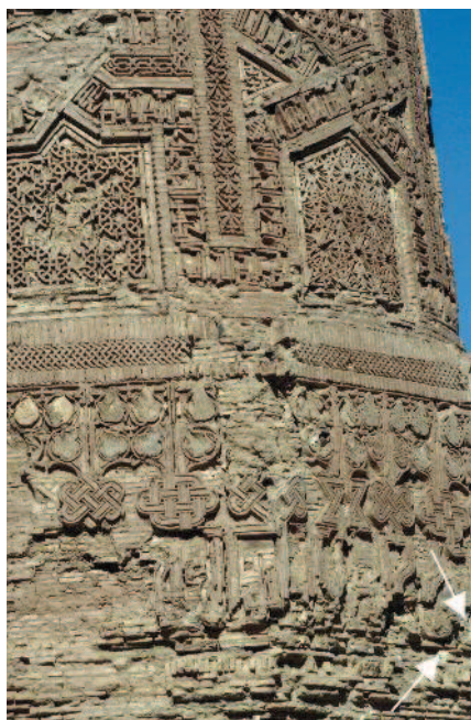
Fig. 9 À droite, face sud-ouest de la base du minaret de Jâm, Afghanistan. Les flèches blanches indiquent les points de prélèvements de mortier pour analyse physique à Bordeaux. Résultat: c'est un mortier composite «gypse – céramique athermique» (ph. Max Schvoerer, 03/09/2003).
