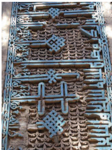
Fig. 8 Herât, Afghanistan. Mosquée du Vendredi datée de 1200 ap. J.C. Élément de décor ghoride, formé de briques glaçurées de couleur bleu turquoise, comme à Jâm. (extérieur, mur est, à proximité de l'entrée du très ancien atelier de céramistes de la mosquée (ph. Max Schvoerer, 30/08/2003).
