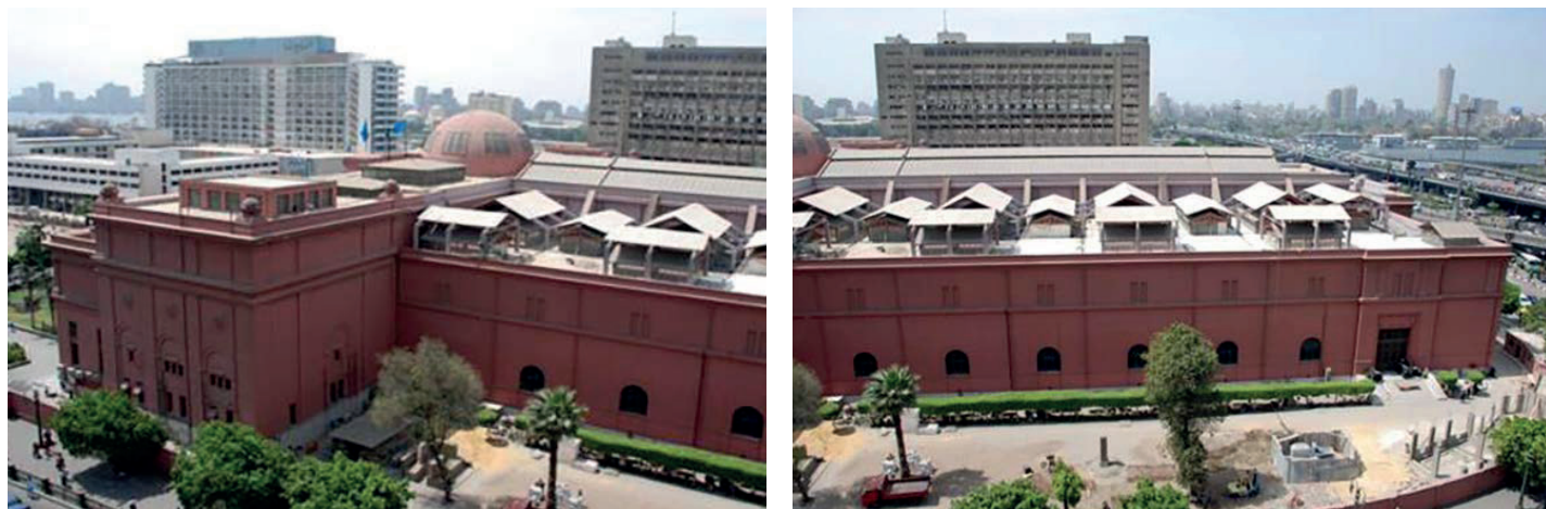
Fig. 7-8 La grande copertura con i lucernai coperti da pesanti strutture in c.a. realizzate per contrastare eventuali possibili attentati; la zona al centro più alta è relativa al grande lucernaio che illumina il grande salone centrale del Museo.
