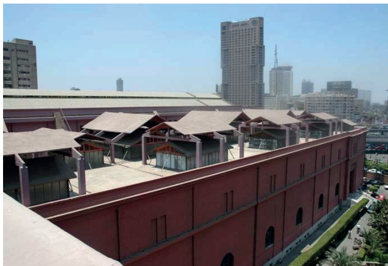
Fig. 14 I lucernai coperti da strutture in c.a. di cui si è prevista la demolizione con il rifacimento di nuove strutture coperte da unità fotovoltaiche e mini brize-soleil per un controllo della quantità di illuminazione naturale all'interno del museo, annullando l'irraggiamento diretto sui materiali esposti.
