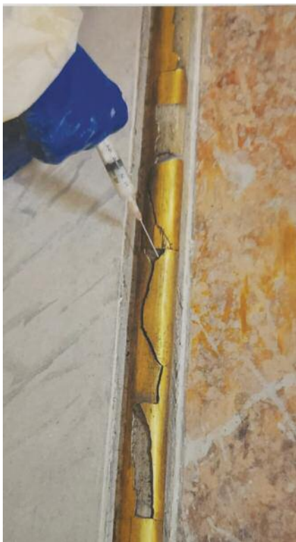
Fig. 22 Consolidamento e fissaggio dei distacchi.
