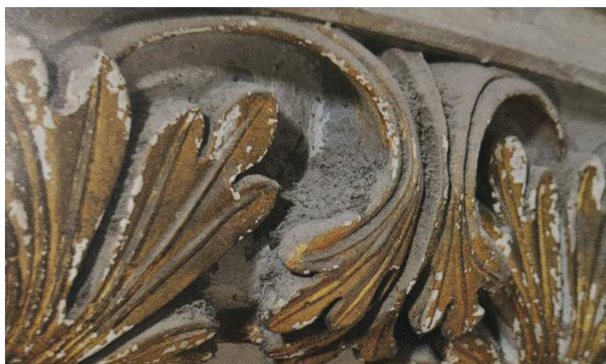
Fig. 11 Microesfoliazione della lamina metallica su elementi lapidei dorati.
