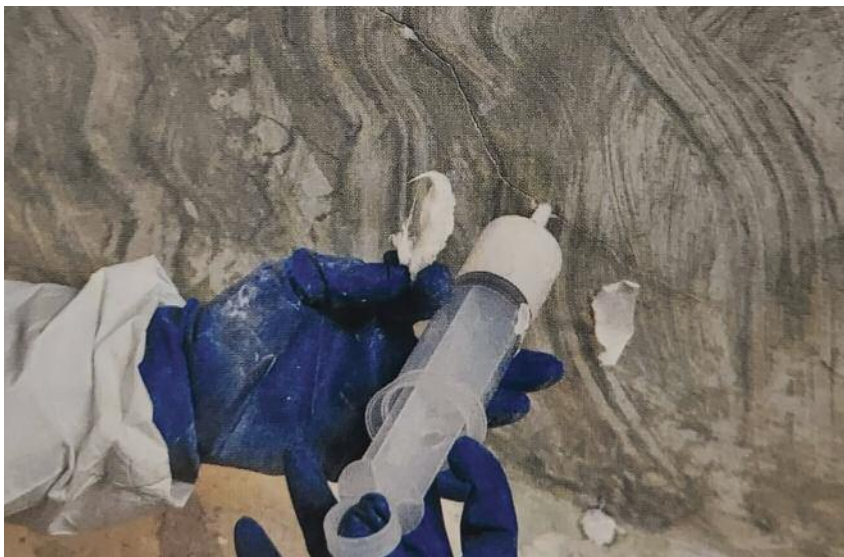
Fig. 21 Consolidamento del supporto.
