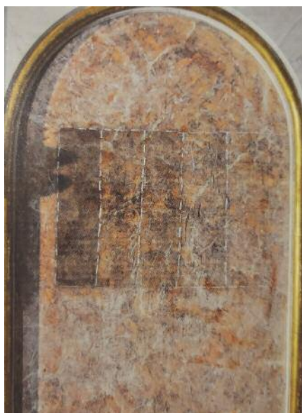
Fig. 15 Tassello stratigrafico definente vari gradi di pulitura.
