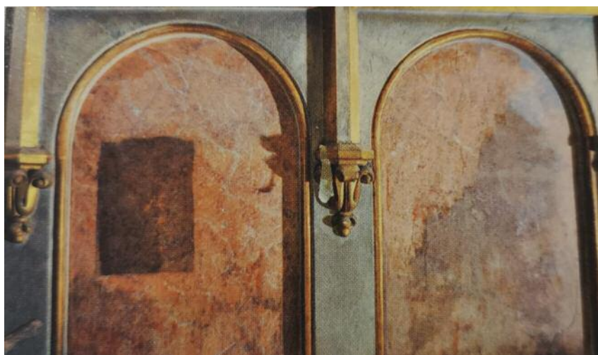
Fig. 16 Fasi della pulitura della decorazione a brecce rosse.
