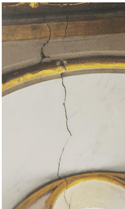
Fig. 10 Lesioni e fessurazioni.
