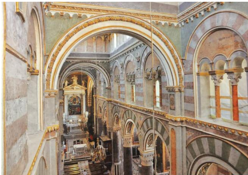
Fig. 2 Generale ingrigimento delle superfici determinato dall'alterarsi di prodotti di protezione superficiale che hanno trattenuto e fissato depositi di sporco, nero fumo e particolato.
