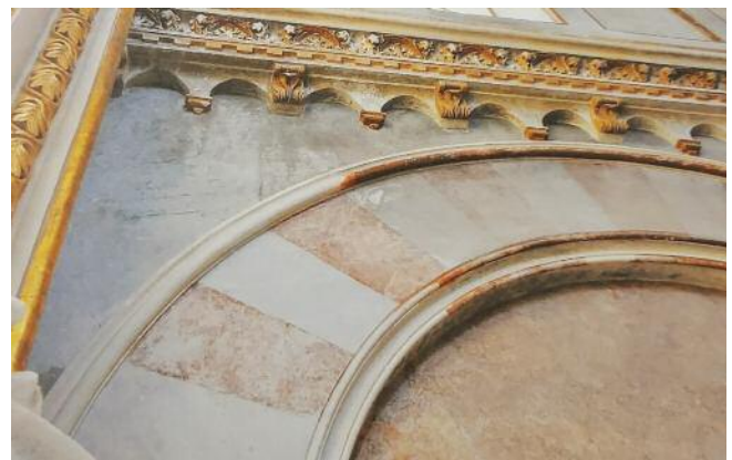
Fig. 8 Estesa area di alterazione delle finiture decorative a causa del persistere di infiltrazioni di acque meteoriche.
