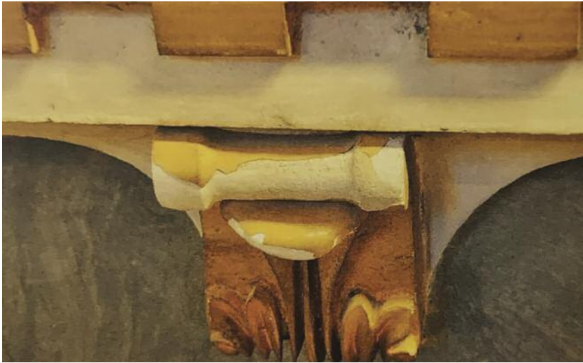
Fig. 13 Distacco della doratura per suscettibilità degli strati di supporto (gessatura e bolo) alle variazioni igrotermiche.
