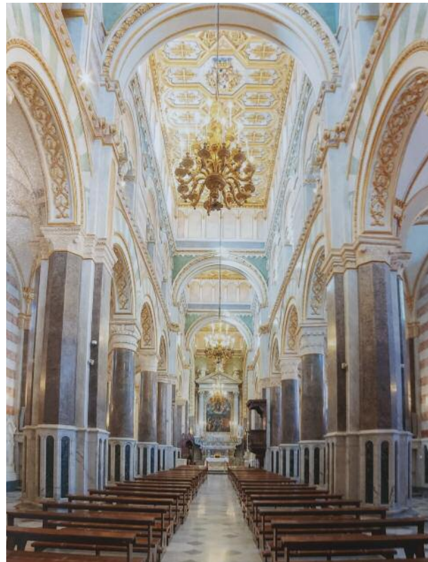
Fig. 32 La navata centrale a fine lavori.
