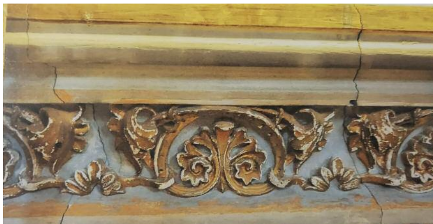
Fig. 9 Lesioni e fessurazioni.
