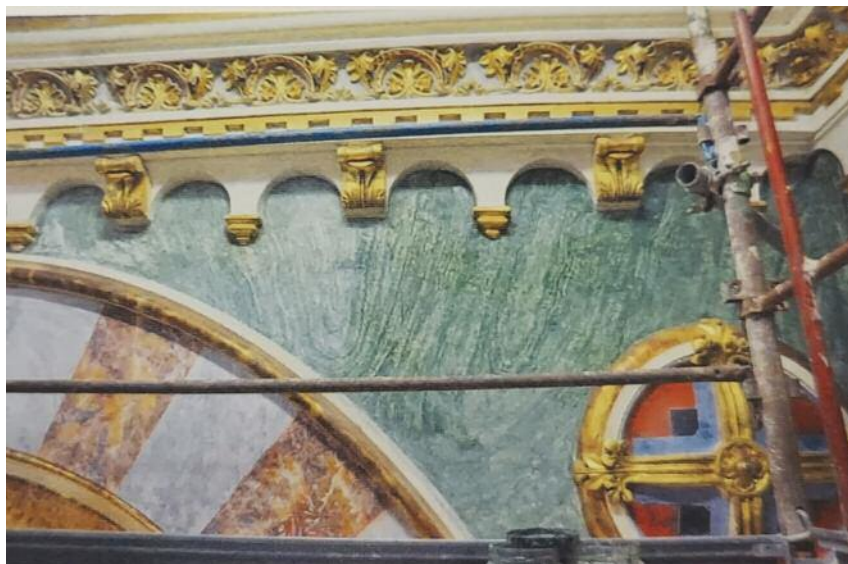
Fig. 23 Integrazione pittorica delle finte brecce verdi.
