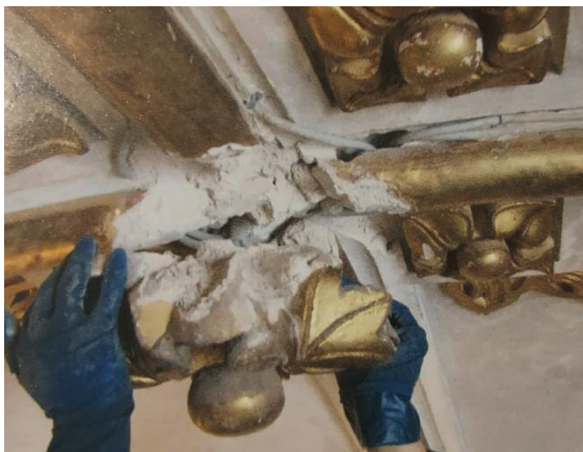
Fig. 27 Verifica dell'ancoraggio degli stucchi in fase di distacco e riposizionamento degli stessi mediante imperniazioni.
