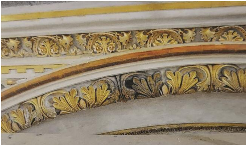
Fig. 20 Tasselli di pulitura delle dorature: in evidenza il recupero dei rapporti cromatici e di luminosità originali.
