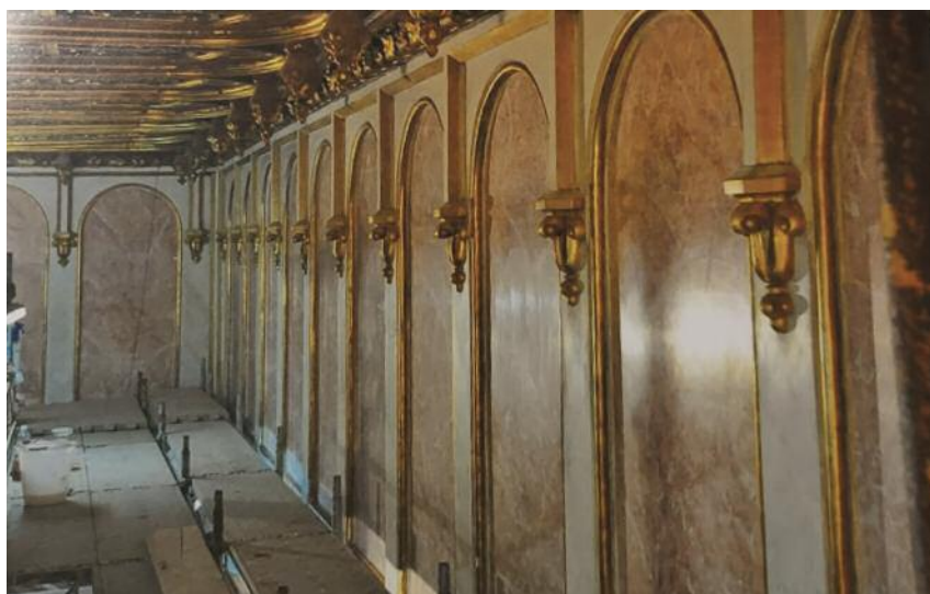
Fig. 24 Applicazione di cera e lucidatura a tampone delle superfici.
