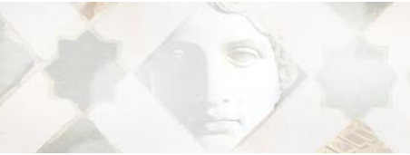
Fig. 2 Generale ingrigimento delle superfici determinato dall'alterarsi di prodotti di protezione superficiale che hanno trattenuto e fissato depositi di sporco, nero fumo e particolato.
