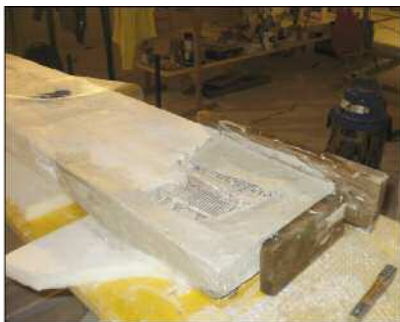
Fig.15 Rinforzo dell'armatura con l'aggiunta di una rete in fibra di vetro; stuccatura e integrazione plastica.
