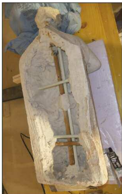
Fig.16 Consolidamento e integrazione delle armature in bambù ammalorate con tondini in vetroresina.
