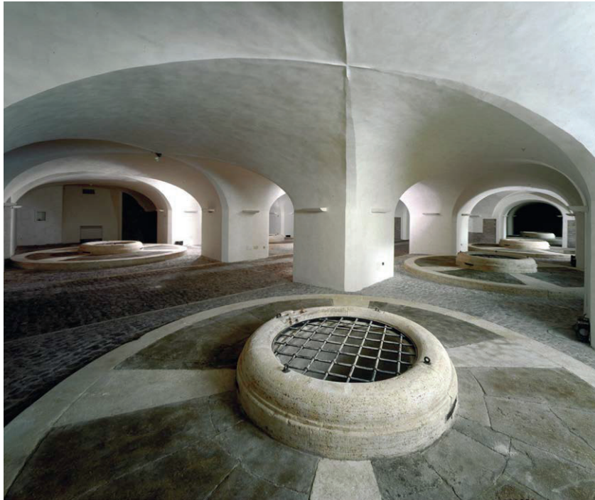
Fig. 6 Le "Olearie" di Clemente XIII (1763): ciascuno dei 10 pozzi dell'Annona Pontificia poteva contenere 44.000 litri d'olio. Attualmente chiuse.
