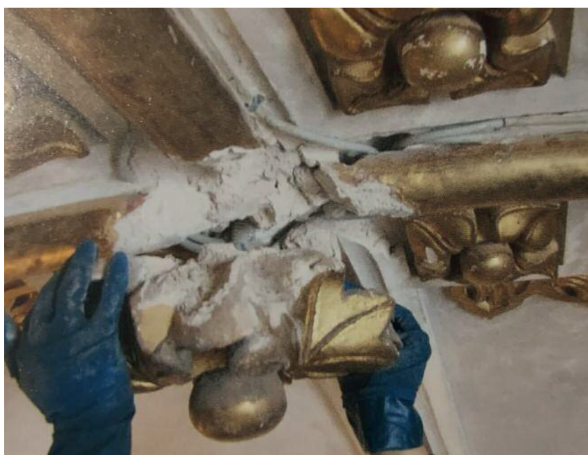
Fig. 27 Verifica dell'ancoraggio degli stucchi in fase di distacco e riposizionamento degli stessi mediante imperniazioni.
