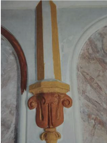
Fig. 28, 29 Integrazione della doratura per le lacune di maggiori dimensioni mediante applicazione di foglia oro zecchino su appretto a mordente, previa preparazione delle superfici con color bolo.
