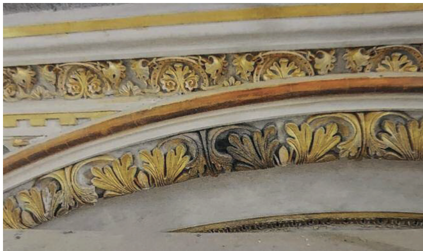
Fig. 20 Tasselli di pulitura delle dorature: in evidenza il recupero dei rapporti cromatici e di luminosità originali.
