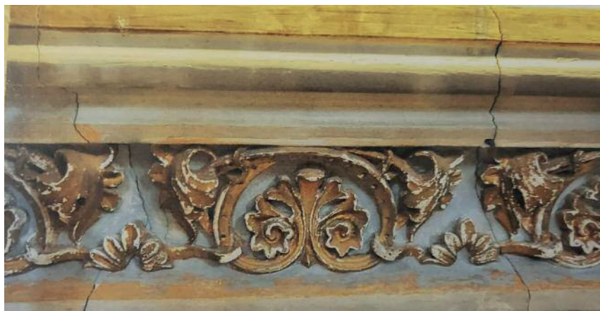
Fig. 9 Lesioni e fessurazioni.
