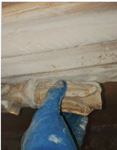
Fig. 25, 26 Imperniazioni e fissaggi di elementi di modellato a rischio di distacco e caduta.
