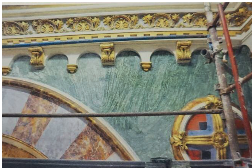
Fig. 23 Integrazione pittorica delle finte brecce verdi.
