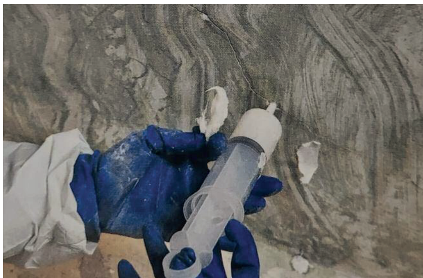
Fig. 21 Consolidamento del supporto.
