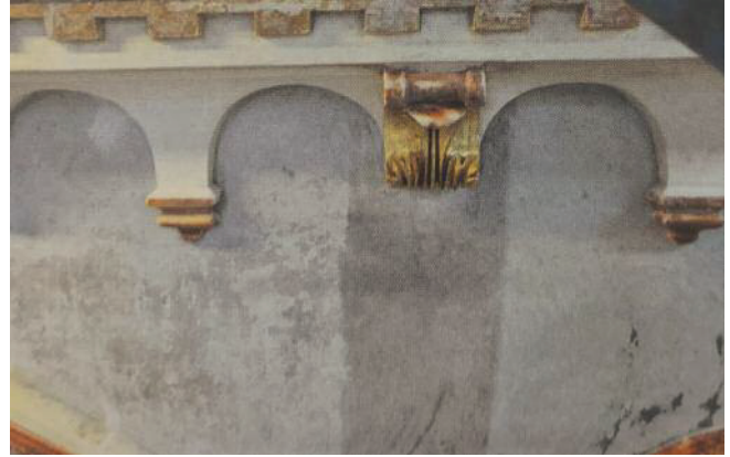
Fig. 5 Immagini di dettaglio relative allo stato di degrado delle decorazioni a "breccia verde": localizzate aree di lacunosità.
