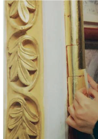
Fig. 30 Integrazione della doratura con applicazione di foglia oro a mordente.
