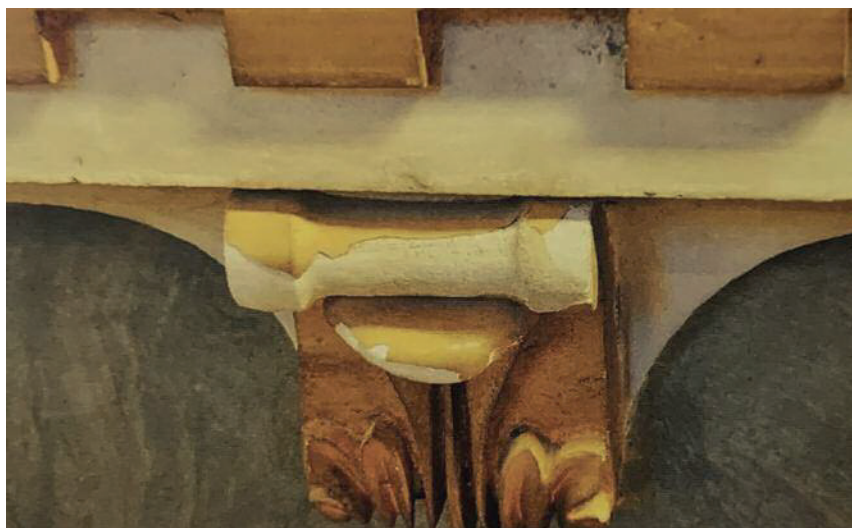
Fig. 13 Distacco della doratura per suscettibilità degli strati di supporto (gessatura e bolo) alle variazioni igrotermiche.
