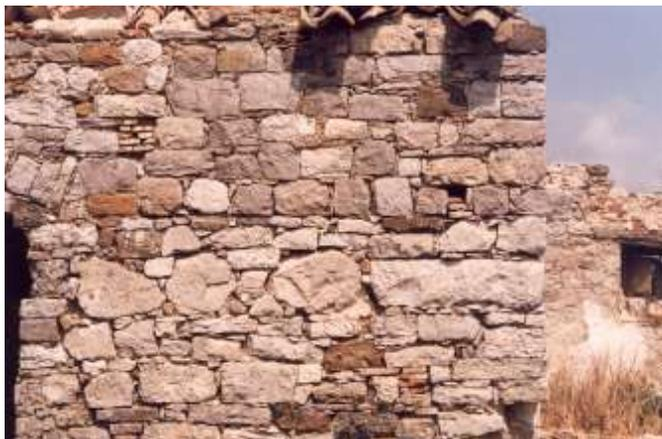
Fig. 14.2 (Aquilonia) - Nella seconda delle tipologie murarie individuate si riscontra, a fronte di un minor impiego di ciottoli, una maggiore diffusione di elementi lapidei più o meno sommariamente sbazzati. Questi apparecchi, ancora composti secondo assisi di ripianamento tendenzialmente irregolari e strati di compianamento posti all'incirca ogni 40-50 cm, presentano una discreta diffusione dei blocchi di forma di parallelepipedo recanti i piani orizzontali sufficientemente spianati.
