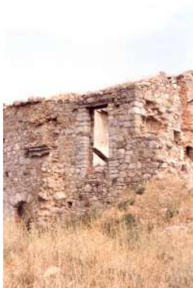
Fig. 55.2 (Aquilonia) - La foto mostra un altro esemplare di architrave, sempre in legno quercia, con caratteristiche identiche all'esempio riportato nella foto precedente. Interessante è rilevare come, secondo la tradizione della locale tecnica costruttiva, gli elementi lapidei sbozzati vengano inseriti non solo nei cantonali di fabbrica ma anche nei piedritti delle aperture.
