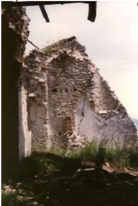
Fig. 10.1 (Senerchia) - Particolare dell'abside della chiesa di S. Michele Arcangelo. Ciò che resta della volta mostra un apparecchio accuratamente realizzato ricorrendo a blocchetti grossomodo regolari di pietra non locale e mattoni posti di coltello.
