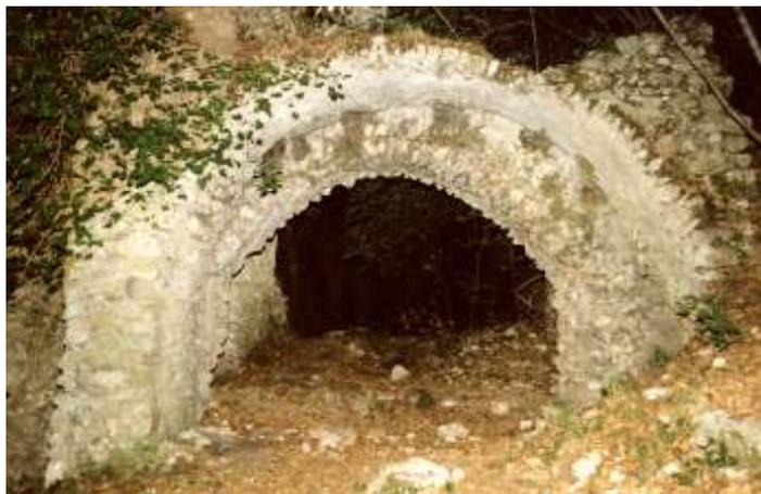
Fig. 3.3 (Amalfi) - Ruederi dell'antica Ferriera. L'arco, di fattura tardo-medievale, e la corrispondente volta a botte sono entrambi realizzati con pietrame calcareo non sbizzato ed abbondante malta di calce.
