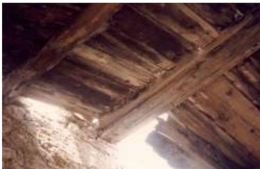
Fig. 60.2 (Aquilonia) - Particolare di una trave di colmo rinforzata con elementi lignei posti sui due lati.
