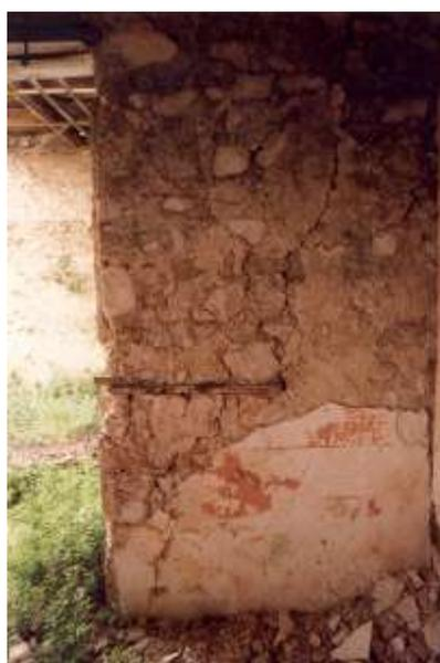
Fig. 47.1 (Senerchia) - Questo sottile elemento ligneo utilizzato quale strato di compianamento nella tradizionale fabbrica di *pietre vive* è stato rinvenuto in una sopraelevazione realizzata al principio del XX secolo.
