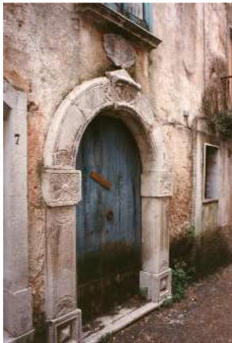
Fig. 27.1 (Senerchia) - Non mancano nei casi di architettura aulica del tessuto urbano portali realizzati con blocchi di bianco *travertino* con *pelle* perfettamente levigata. Qui vediamo l'esempio del settecentesco portale di palazzo Frunzi.
