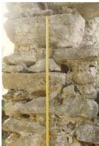
Fig. 35.3 (Pontone, Scala) - Castrum Scalelle. Cantonale del muro della fig. 32.3. Si veda come i già ricordati grossi blocchi lapidei di forma di parallelepipedo molto allungato, corrispondono alla precisa intenzione di ben ammorsare il cantonale. Gli elementi in questione presentano, inoltre, i piani orizzontali sommariamente spianati.
