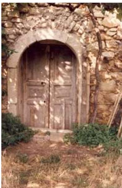
Fig. 52.2 (Aquilonia) - Il portale, a tutto sesto, è realizzato mediante conci di pietra calcarea grigia a *pelle bocciardata* e con *fettuccia*. Significativo - ed anche molto diffuso nel sito in esame - è lo scivolamento del concio di chiave.
