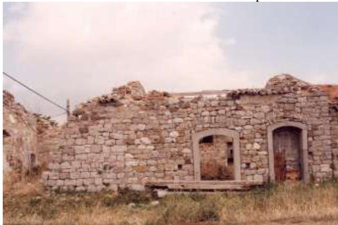
Fig. 27.2 (Aquilonia) - Gli apparecchi murari qui raffigurati mostrano, pur appartenendo alla medesima classe tipologica, alcuni interessanti elementi di distinzione. In particolare, la porzione di muratura localizzata a sinistra della foto - sicuramente antecedente alla parte di fabbrica sulla destra - mostra delle evidenti dissonanze rispetto all'apparecchio murario tipo della seconda classe.
