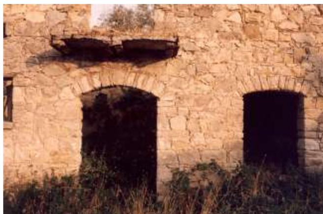
Fig. 10.2 (Aquilonia) - Qui gli elementi fittili - mattoni correnti e *mattoncelle* - sono stati anche utilizzati nella confezione degli archi unitamente alla tradizionale pietra locale (calcare ed arenarie). Quest'ultima, in particolare, viene
