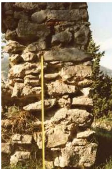
Fig. 34.3 (Pontone, Scala) - Castrum Scalelle. Porzione orientale della muratura della fig. 32.3. E' possibile verificare, oltre alla già citata maggiore ricorrenza di grossi scheggioni calcarei, la presenza di blocchi dalla forma molto allungata, utilizzati nel cantonale di fabbrica.
