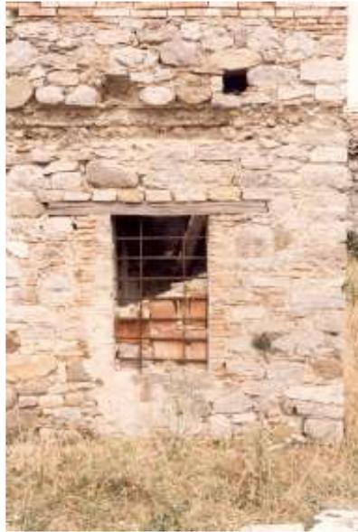
Fig. 54.2 (Aquilonia) - Uno dei pochi esemplari superstiti di architrave ligneo. Singolare è il robusto spessore (circa 12-13 cm.) che connota la totalità degli esempli analizzati.
