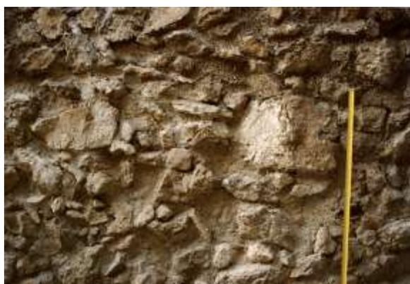
Fig. 16.3 (Pontone, Scala) - Campanile del S. Filippo Neri, particolare del basamento. Il campanile, la cui originaria struttura risale al XII secolo, mostra un apparecchio murario privo di cantieri e nel quale trovano elevata diffusione gli irregolari elementi lapidei di piccolo volume. I conci più ricorrenti hanno, infatti, lunghezze all'incirca comprese tra 10 e 15 cm ed altezze di 5-10 cm.
