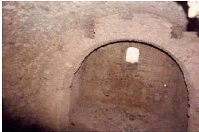
Fig. 46.2 (Aquilonia) - Palazzo Vitale. Arco intermedio realizzato per il rafforzamento della volte a botte.
