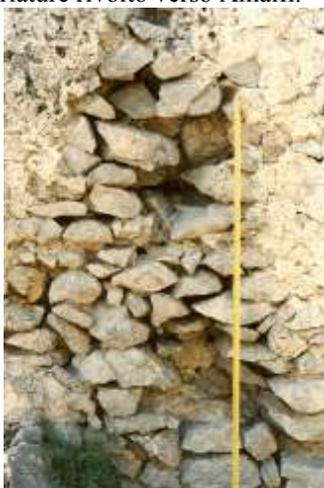
Fig. 22.3 (Pontone, Scala) - Resti della fortificazione della Rocca S. Felice. Particolare della muratura illustrata nella fig. 20.3. E' visibile il cantiere - posto a circa 80 cm. da terra - e la netta prevalenza degli irregolari elementi lapidei di volume modesto.
