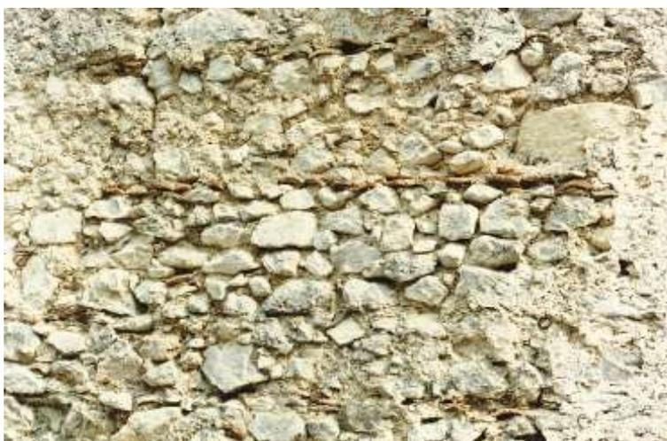
Figg. 23.1 e 24.1 (Senerchia) - Ancora due esemplari di murature appartenenti alla quarta delle tipologie individuate. Oltre alla già citata sovrabbondanza di pietre di piccolo volume è evidente, dal confronto tra i due campioni, la variabilità della distanza a cui vengono posti i periodici ricorsi di orizzontamento all'interno della stessa classe. Mentre, infatti, nella fig. 23.1 i cantieri distano in media circa 40cm, nella fig. 24.1 i citati ricorsi compaiono all'incirca ogni 65 cm.
