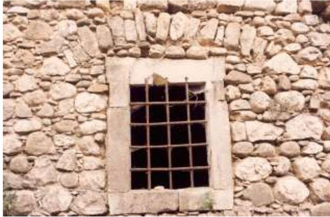
Fig. 41.2 (Aquilonia) - Palazzo Vitale. Fronte orientale. Particolare di un arco di scarico del sottostante architrave lapideo.
