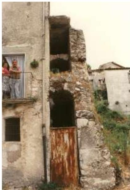
Fig. 36.1 (Senerchia) - Un altro esemplare di struttura di contrasto posta tra due edifici dei quali, quello sulla destra della foto, su piazza Umberto I, è stato demolito dopo il sisma del 23 novembre 1980.
