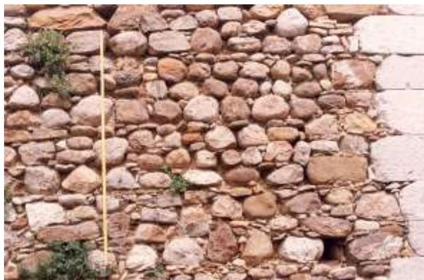
Fig. 13.2 (Aquilonia) - Il campione rinvenuto nel palazzo Vitale, appartiene alla prima delle tipologie murarie individuate. Le murature classificate nel primo gruppo sono prevalentemente composte da ciottoli, breccie, frammenti di cotto ed, in minor misura, da pietre rustiche. I ciottoli, anche spaccati, e gli scheggiosi sono messi in opera
