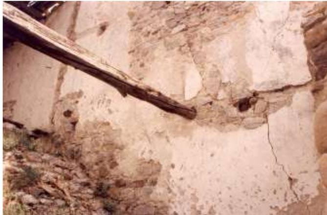
Fig. 57.2 (Aquilonia) - Come si evince dalla fotografia nessuna particolare cura veniva posta nella realizzazione degli alloggi dei travi nei muri. Essi, infatti, erano semplici incassati a secco servendosi di breccie e di frammenti dei elementi fittili.
