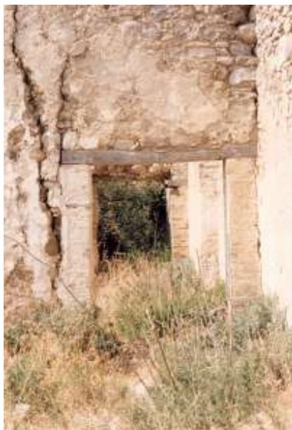
Fig. 8.2 (Aquilonia) - Palazzo Vitale. Tutte le aperture delle partizioni interne ai locali terranei della fabbrica sono state ricostruite, più ampie, utilizzando le citate *mattoncelle* per i piedritti e robusti architravi lignei. Dalla foto è immediato verificare lo scarso ammorsamento realizzato tra le due distinte murature evidenziato dalla presenza di profonde lesioni.
