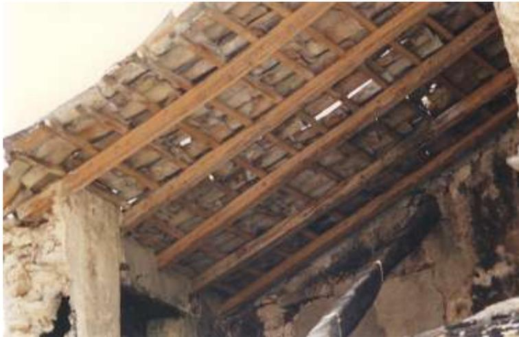
Fig. 54.1 (Senerchia) - Talvolta al tradizionale sottomanto realizzato con l'*assito* di tavole si sostituisce un'orditura di correntini direttamente sovrapposta ai paradossi.
