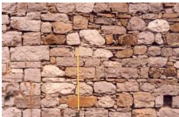
Fig. 22.2 (Aquilonia) - Apparecchio murario appartenente alla seconda classe tipologica. E' immediata verificare la più limitata diffusione dei ciottoli e fronte di un uso allargato di elementi di cava. La murature in questione sono ancora composte secondo assisi di ripianamento tendenzialmente irregolari e presentano periodici ricorsi di compianamento all'incirca ogni 40-50 cm. Inoltre, rispetto alla prima tipologia, si nota l'utilizzo di elementi lapidei sbozzati non più
