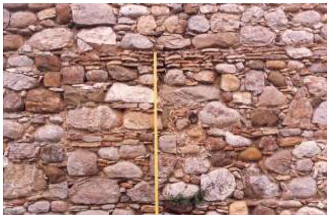
Fig. 19.2 (Aquilonia) - Fattore ricorrente nell'intera campionatura è la poca cura riposta negli ammorsamenti di fabbrica. In particolare, ciò è evidente nei casi, come quello qui raffigurato, di sostruzioni murarie.
