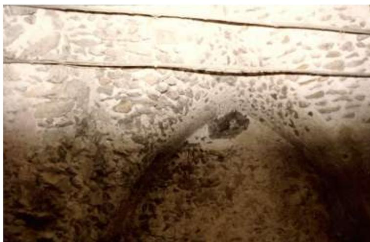
Fig. 5.3 e 6.3 (Pontone, Scala) - Cavalcavia su via Pisacano. Nella struttura medievale è visibile l'apparecchio della volta a crociera ad otto spicchi realizzato in modo che, in ogni unghia, i filari siano pressappoco perpendicolari ai muri d'ambito.
