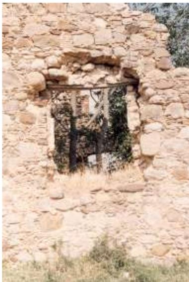
Fig. 48.2 (Aquilonia) - Palazzo Vitale. Carbonara-Aquilonia, dopo l'abbandono del centro verificatosi a seguito del sisma del 1930, ha subito diffusissime popolazioni. Qui, è raffigurato il caso di un'apertura da cui sono stati asportati gli elementi lapidei che sicuramente la inquadravano, secondo una tipologia molto diffusa nella zona.
