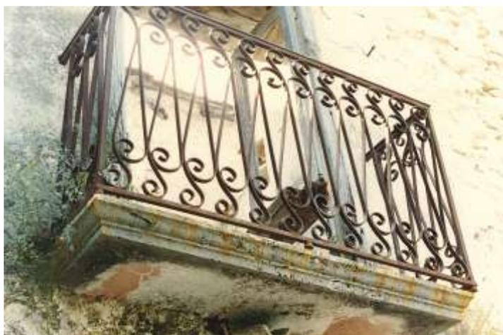
Fig. 30.1 (Senerchia) - I tradizionali tavoloni di balcone di Senerchia sono stati, purtroppo, quasi interamente sostituiti con solette in cemento armato. Qui vediamo uno dei pochi casi superstiti realizzato con una lastra monolitica di calcare.
