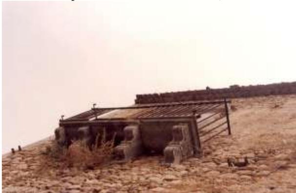
Fig. 51.2 (Aquilonia) - Fronte orientale di palazzo Vitale. La foto raffigura uno dei due esemplari superstiti di tavolone di balcone appartenenti alla fabbrica in oggetto. L'elemento sporgente, costituito da una lastra monolitica, è retto mediante quattro mensole realizzate nella medesima varietà litoide e finemente scolpite.
