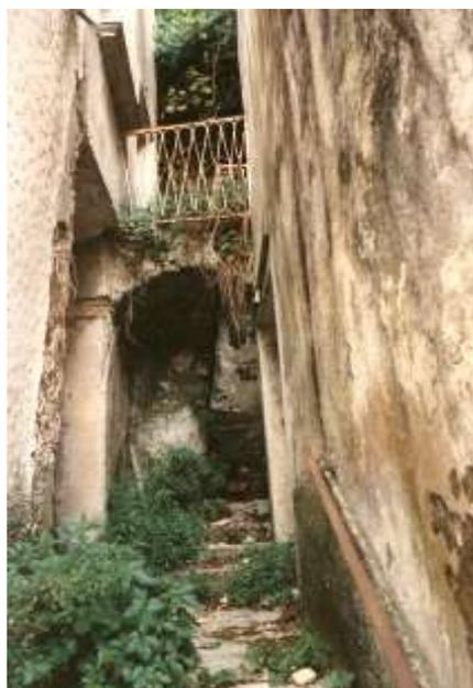
Fig. 35.1 (Senerchia) - Gli archi di contrasto, particolarmente diffusi nella porzione di tessuto posta a valle dell'insediamento più antico, assolvono spesso ad una duplice funzione. Da una parte essi migliorano, infatti, la vulnerabilità dell'edificato e dall'altra, qualora su di essi si innestino vani abitabili, consentono un allargamento della superficie residenziale.
