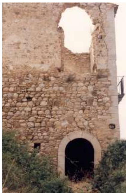
Fig. 15.2 (Aquilonia) - Nella prima delle tipologie murarie individuate le pietre sbazzate hanno un impiego limitato alla sola realizzazione dei cantonali di fabbrica.
