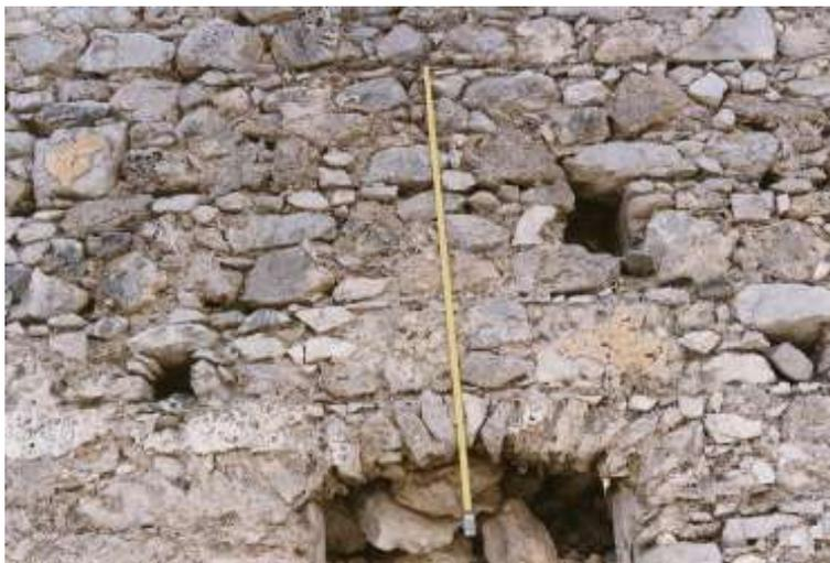
Fig. 21.1 (Senerchia) - Apparecchiatura muraria appartenente alla quarta delle classi tipologiche individuate. Vi si nota - pur nell'invarianza di alcuni parametri, quali altezza dei cantieri (all'incirca pari a 40-65cm) e utilizzo diffuso di frammenti di coppi - un maggior impiego di elementi lapidei di scarsa consistenza. Probabilmente, la sovrabbondanza di queste pietre più piccole può essere addebitata alla volontà di riutilizzare il materiale calcareo ricavato da crolli o demolizioni.
