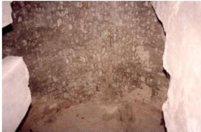
Fig. 42.2 (Aquilonia) - Palazzo Vitale. L'apparecchio dell'imponente volte a botte è realizzato ricorrendo a ciottoli, per lo più spaccati, e pietre rustiche inseriti perpendicolarmente alla superficie d'intradosso.
