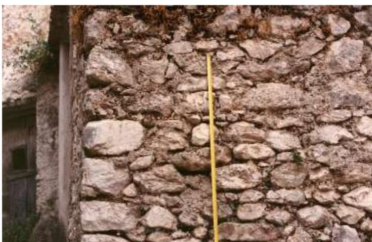
Figg. 19.1 e 20.1 (Senerchia) - Murature appartenenti alla terza delle classi tipologiche individuate. Gli scheggioni di pietra calcarea, generalmente ben assortiti, sono qui disposti secondo periodici ricorsi di orizzontamento posti all'incirca ogni 50-60 cm, come accadeva per gli apparecchi murari della prima classe. Ciò che distingue questi parametri da quelli del primo gruppo è il diffuso utilizzo di frammenti di tegole curve come elementi di rinzeppatura.
