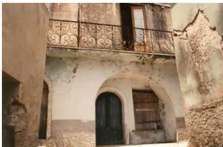
Figg. 37.1 e 38.1 (Senerchia) - L'edificio posto sul versante orientale di via Umberto I. è stato fatto visibilmente oggetto di un intervento di riparazione post-sismico realizzato attraverso l'ispessimento della facciata principale.
