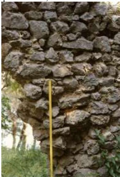
Fig. 25.3 (Pontone, Scala) - Castrum Scaelle. La muratura ivi raffigurata non presenta ricorsi di orizzontamento fatta
