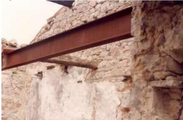
Fig. 58.2 (Aquilonia) - Il caso in oggetto rappresenta uno dei vari esempi rilevati di solaio ligneo consolidato mediante l'inserimento di putrelle disposte ortogonalmente ai travi.
