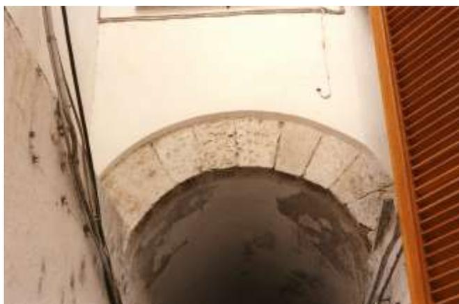
Fig. 48.3 (Amalfi) - Salita Episcopo. L'arco, che chiude il passaggio voltato, è realizzato con conci accuratamente sbozzati di tufo giallo napoletano. Un leggero scialbo di colore bianco ne ricopre la faccia a vista.
