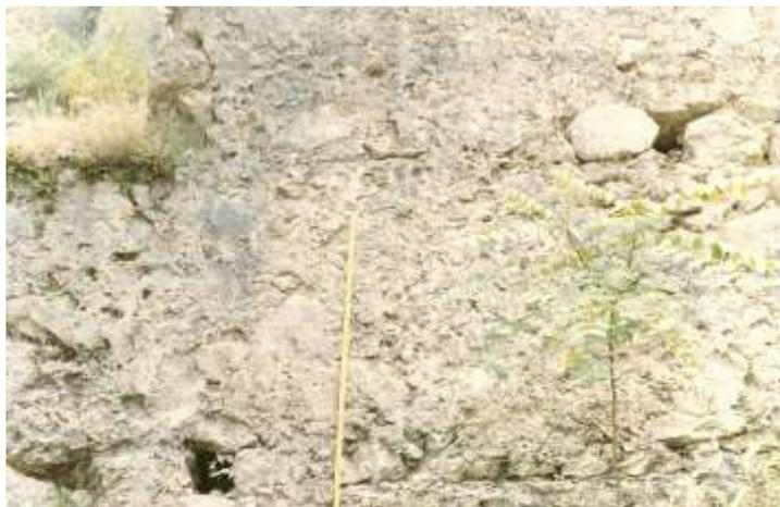
Fig. 12.1 (Senerchia) - Il brano murario ivi raffigurato rappresenta un caso particolare della prima delle tipologie individuate. Pur presentando, infatti, l'esistenza di periodici ricorsi di orizzontamento e l'assenza dei frammenti di coppi, qui i citati ricorsi (*cantieri*) sono posti a distanze superiori, mediamente, al metro fino ad un massimo di 1.30 m.
