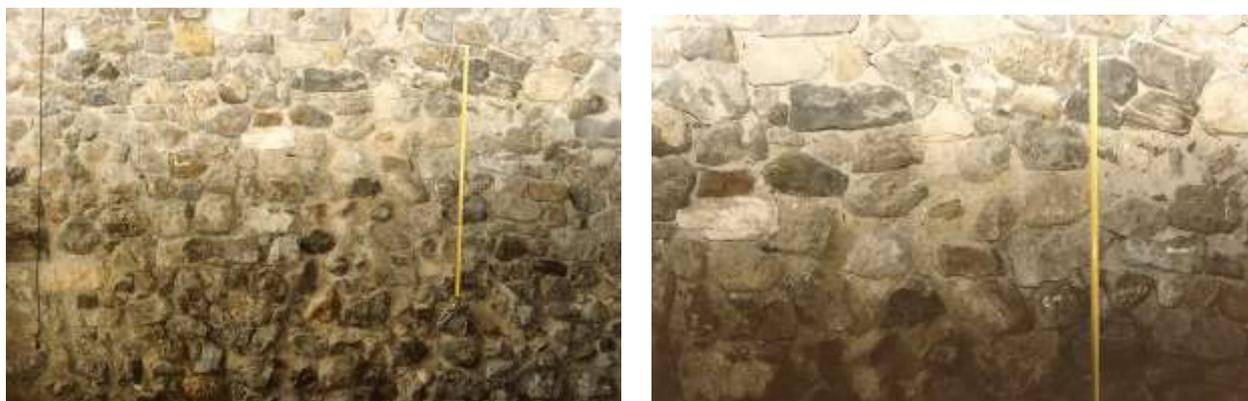
Figg. 14.3 e 15.3 (Amalfi) - Arsenali. Questo campione appartiene alla parete occidentale della fabbrica, alla seconda campata da sud. Se lo si confronta con le immagini precedenti è immediato verificare che, a fronte di una più difficoltosa individuazione dei cantieri - praticamente assenti se si eccettua un unico orizzontamento posto a circa 90 cm da terra - gli elementi lapidei sono, però, meglio assortiti assumendo, generalmente, volumi pressappoco uguali.
