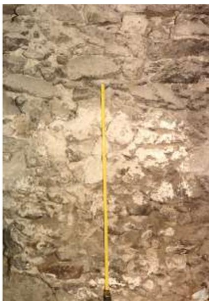
Fig. 43.3 (Pontone, Scala) - Via Pisacano. La muratura è realizzata a cantieri di altezza pressappoco costante. In particolare il primo, da terra, è alto circa 70 cm., i successivi sono mediamente di 65 cm. Gli irregolari conci lapidei sono di volume medio-grande mentre il pietrame più piccolo è utilizzato quale materiale di rinzeppatura.
