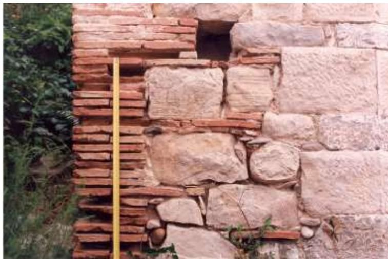
Fig. 7.2 (Aquilonia) - La foto mostra il particolare di una bucatura cui è stata ridotta la luce ricorrendo ad una muratura in pietra locale e parziale utilizzo di sottili elementi laterizi. La forma e le dimensioni di questi (cm. 24 x 12 x circa 2), paragonabili alle *mattoncelle partenopee*, indurrebbe a datare il consolidamento in oggetto intorno al XIX secolo.
