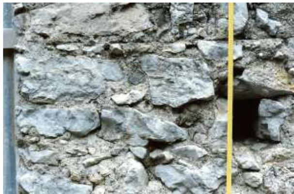
Figg. 37.3 e 38.3 (Amalfi) - Valle dei Mulini. Cartiera. Gli apparecchi murari dell'edificio in questione sono realizzati a cantieri - mediamente di altezze comprese tra 48 e 55 cm. - e con *scheggioni di pietra viva* di volume medio-grande. Per pareggiare gli orizzontamenti suddetti e per riempire i vuoti risultanti tra le irregolari superfici dei conci più grandi, viene usato sia il pietrame minuto che i frammenti di cotto (laterizi e tegole curve).
