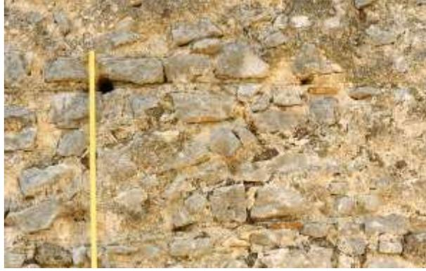
Fig. 30.3 (Amalfi) - La Torre dello Ziro. Particolare della fig. 29. I cantieri - di altezza compresa tra 58 e 65 cm - sono pareggiati mediante l'impiego del tradizionale brecciamme e di rari frammenti di sottili laterizi.
