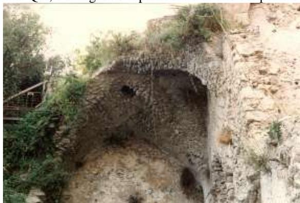
Fig. 8.3 (Pontone, Scala) - Casa medievale. Si vedono i resti delle volte a crociera - ad otto spicchi e privi di costoloni - apparecchiate, in ciascuna unghia, con irregolari elementi calcarei, posti di coltello, secondo filari grossomodo perpendicolari ai muri d'ambito.
