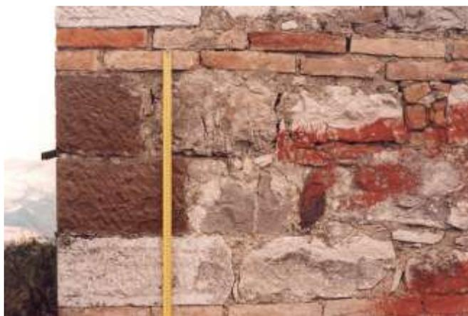
Fig. 37.2 (Aquilonia) - Particolare del cantonale occidentale dell'edificio (fig. 4.2) sito in largo Croce. Anche qui gli elementi lapidei sono gerarchizzati ed evidenziati ricorrendo, oltre ad un diverso grado di finitura della faccia vista, anche ad una diversa colorazione.
