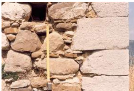
Figg. 35.2 e 36.2 (Aquilonia) - Palazzo Vitale. Fronte meridionale. Esempio di cantonale di fabbrica realizzato con elementi gerarchizzati ed evidenziati.
