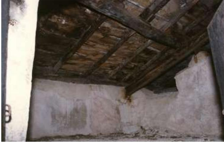
Fig. 53.1 (Senerchia) - Ambienti adiacenti la chiesa di S. Michele Arcangelo. Copertura ad una *penna* realizzata con una trave principale, a giacitura orizzontale, e paradossi inclinati.
