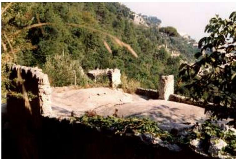
Fig. 1.3 (Amalfi) - Copertura a volte estradossate lungo dia Pestrofa. La foto illustra uno dei pochi esemplari di *battuto di lapillo*, per fortuna, ancora non sostituito dalle guaine bituminose.
