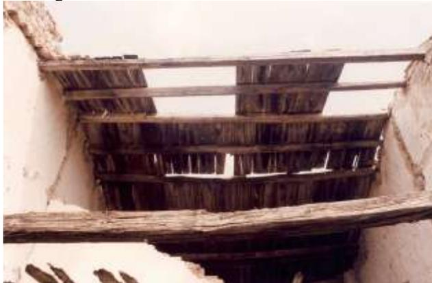
Fig. 59.2 (Aquilonia) - Uno dei rari esemplari superstiti di strutture di copertura. Le due *penne* sono realizzate con una semplice orditura costituita da arcarecci disposti orizzontalmente. Il sottotetto è composto da un assito di tavole.
