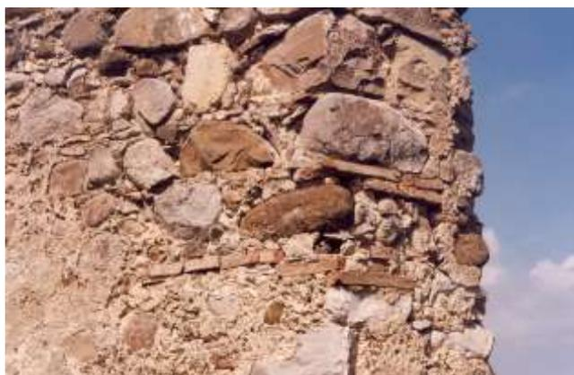
Fig. 9.2 (Aquilonia) - Palazzo Vitale. Particolare di una delle aperture poste sul fronte orientale del fabbricato. Anche qui si notano, accanto ai consueti elementi lapidei, le citate *mattoncelle*. La circostanza in base alla quale nelle murature correnti della fabbrica tali elementi fittili risultano assenti induce a considerare questo particolare caso come un intervento successivo, probabilmente ascrivibile al XIX secolo.
