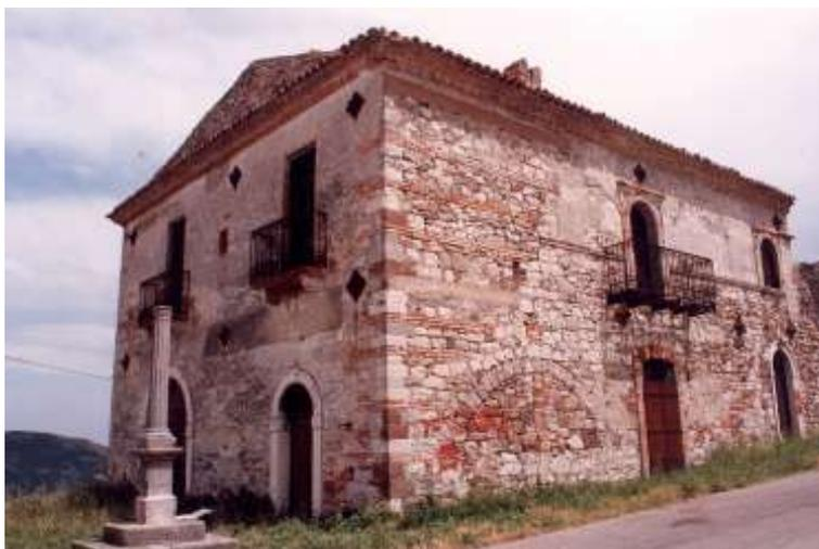
Fig. 5.2 (Aquilonia) - Edificio sito in largo Croce. La fabbrica, gravemente danneggiata dal sisma del 1930, venne parzialmente ricostruita ricorrendo all'*opera listata* in laterizio e pietra locale. La completa rifazione degli orizzontamenti e della copertura e la creazione di un cordolo in c.a. completò l'intervento.
