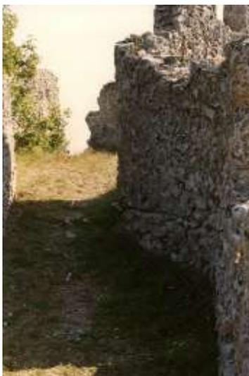
Fig. 23.3 (Pontone, Scala) - Resti della fortificazione della Rocca S. Felice. La foto, che illustra un particolare del fronte interno del muro rivolto verso Amalfi, mette in evidenza l'esistenza dei citati cantieri posti, all'incirca, ad una distanza di 80-85 cm.
