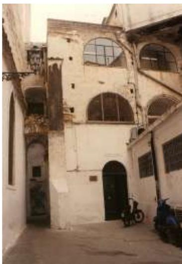
Fig. 45.3 Ex Monastero della SS. Trinità. Fronte su Supportico S. Andrea. Si nota l'opera *listata* - tufo giallo napoletano e laterizio - con cui è realizzato almeno il primo ed il secondo livello del corpo di fabbrica in questione. Sulla sinistra è visibile un piccolo arco di contrasto, composto con conci cuneiformi accuratamente sbozzati di tufo giallo.
