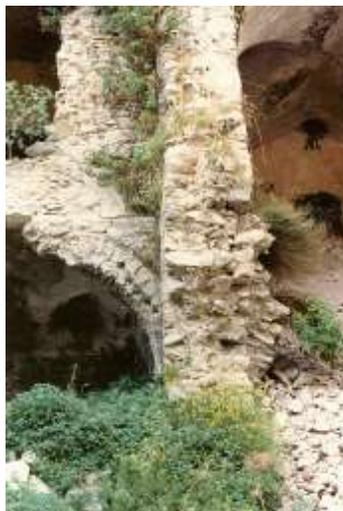
Fig. 19.3 (Pontone, Scala) - Casa Medievale. E' qui riportato un esemplare di tarsia muraria a *fiamma* bicolore, realizzata con elementi in tufo giallo e grigio.
