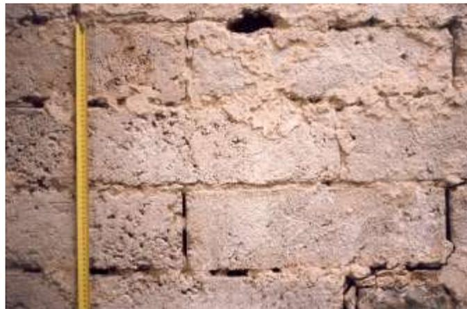
Fig. 32.2 (Aquilonia) - In questo caso i grossi blocchi di tufo, evidentemente standardizzati, sono impiegati per la realizzazione del muro interno che porta la scala.
