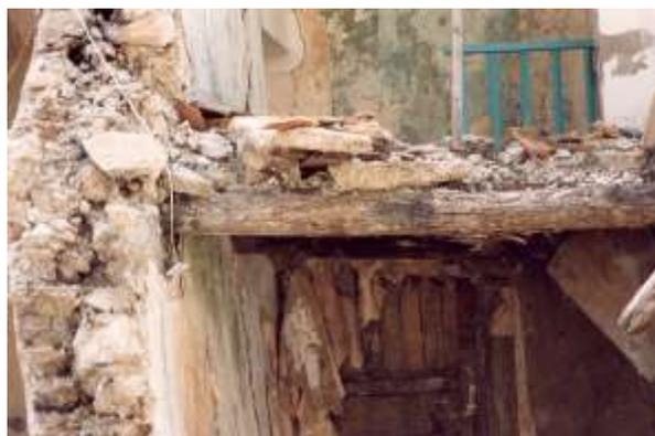
Fig. 49.1 e 50.1 (Senerchia) - Ulteriori esemplari di solai realizzati con travi grezze di castagno. E' visibile la cura riposta nella realizzazione degli alloggi delle teste dei travi nel muro volti a permettere un certo grado di scorrimento orizzontale.
