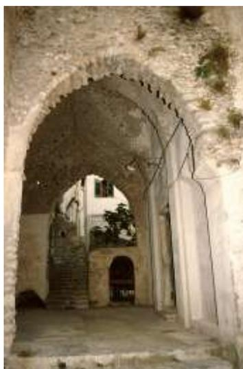
Fig. 9.3 (Pontone, Scala) - Atrio della chiesa di S. Filippo Neri. La struttura, costituita da tre volte estradossate a crociera con otto spicchi, risale al XII secolo allorquando, cioè, la famiglia scalese dei Bonito fondò la chiesa intitolandola a S. Matteo Evangelista. L'atrio, di recente sottoposto ad alcuni restauri, è situato, secondo una tipologia molto ricorrente nella zona, a cavallo della strada pubblica.
