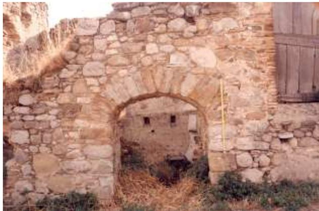
Fig. 39.2 (Aquilonia) - Ancora un altro dei numerosi casi in cui per la realizzazione degli archi si ricorre a blocchetti, grossomodo cuneiformi, in pietra locale ad inserimento radiale.
