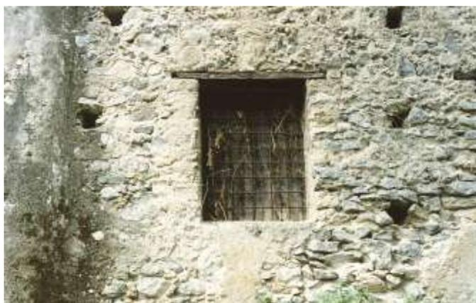
Fig. 41.3 (Amalfi) - Valle dei Mulini. Cartiera Milano. L'apparecchio, anche se disturbato dalla presenza dell'intonaco, si presenta realizzato con pietrame di volume medio-piccolo disposto a cantieri di circa 60 cm. Assenti, in questa parte della fabbrica, i frammenti di cotto.
