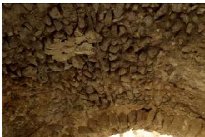
Fig. 4.3 (Pontone, Scala) Cavalcavia su via Tuoro. E' visibile l'apparecchio della volta realizzato con pietrame calcareo irregolare, posto di coltello perpendicolarmente alle linee d'imposta.
