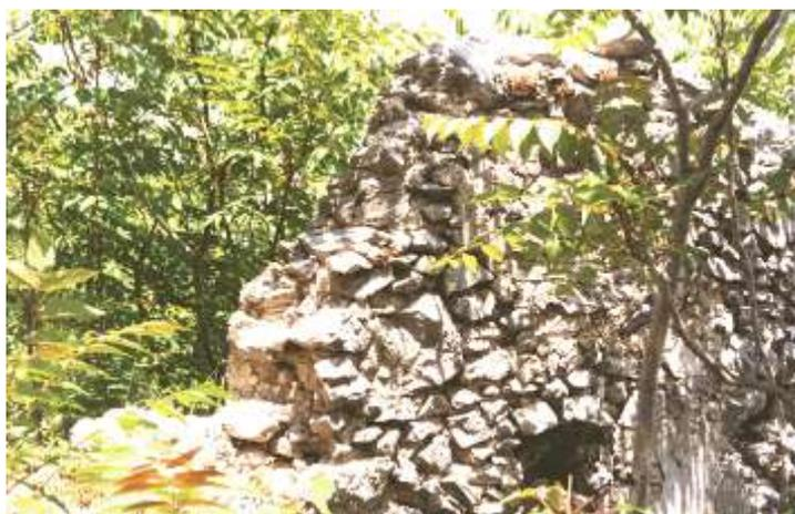
Fig. 13.1 (Senerchia) - Ancora una muratura appartenente alla prima classe tipologica. Nella foto è visibile il mediocre ingranamento realizzato tra le pietre costituenti il muro le quali, anche quando sovrapposte, mai oltrepassano la metà dello spessore murario.
