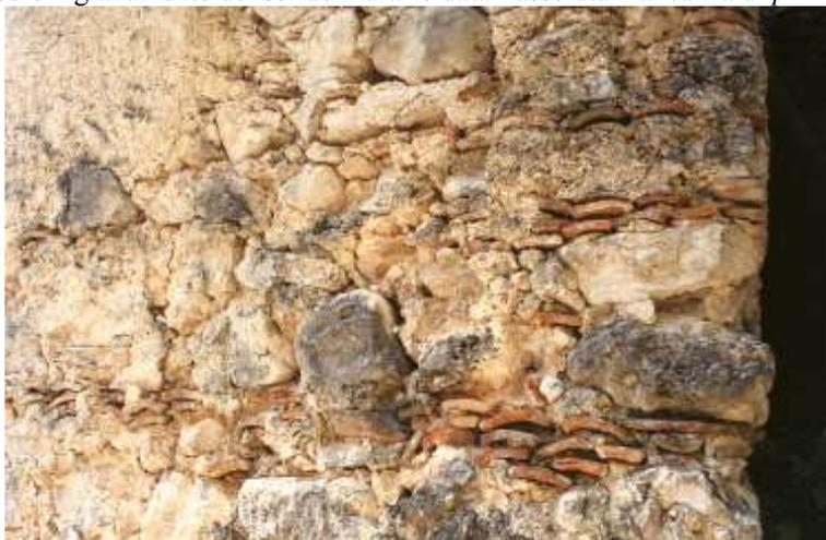
Fig. 18.1 (Senerchia) - Nelle murature appartenenti alla seconda classe molto frequente è l'impiego dei frammenti di tegole curve quali elementi di rinzeppatura. Talvolta, i suddetti spezzoni di tegole si possono trovare anche messi in opera in più strati sovrapposti.
