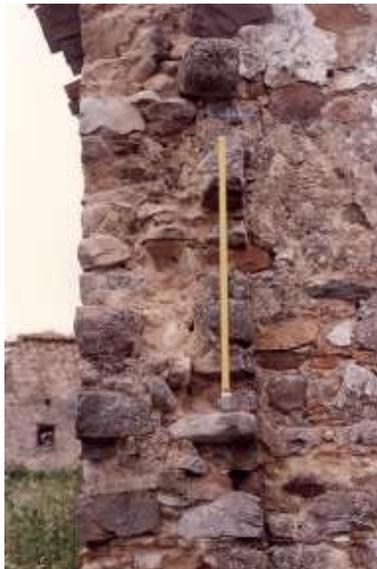
Fig. 23.2 (Aquilonia) - Anche nella seconda classe delle tipologie murarie è evidente la scarsa cura riposta nell'ammorsamento del singolo solido murario. Nonostante, infatti, il livello di ingranamento tra gli elementi lapidei sia senz'altro più alto comunque mai si ritrovano in opera le cosiddette *pietre passanti*.
