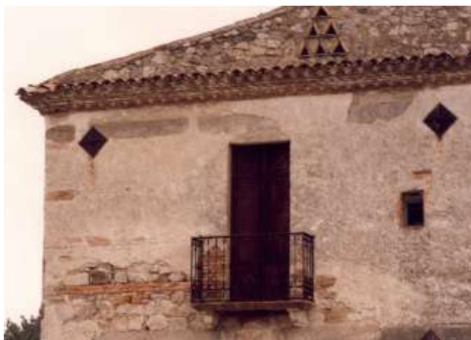
Fig. 12.2 (Aquilonia) - Edificio sito in largo Croce. E' qui evidenziata l'interessante soluzione adottata per il cornicione di coronamento realizzato in più strati, variamente sovrapposti, di tegole curve. Sono visibili, inoltre, i fori d'aerazione del vano sottotetto e gli elementi in ferro che incatenano l'intero edificio.
