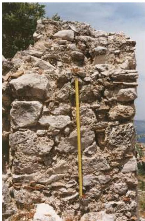
Fig. 22.1 (Senerchia) - Constatato il maggior utilizzo di pietre di scarsa consistenza nelle murature del quarto tipo, è immediato verificare lo scarso ingranamento realizzato. Gli elementi lapidei, infatti, anche quando posti di punta, non riescono nemmeno a raggiungere la metà dello spessore murario.
