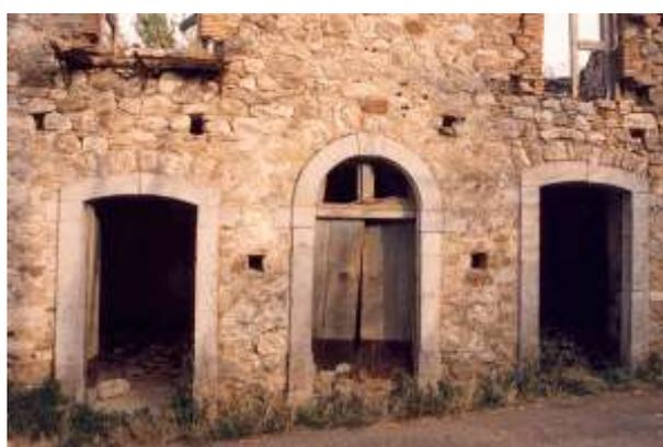
Figg. 25.2 e 26.2 (Aquilonia) - Entrambi i casi qui riportati appartengono alla seconda classe delle tipologie murarie. Anche in questo gruppo, analogamente al primo, molto frequente è l'impiego di frammenti di laterizio (mattoni e coppi)
