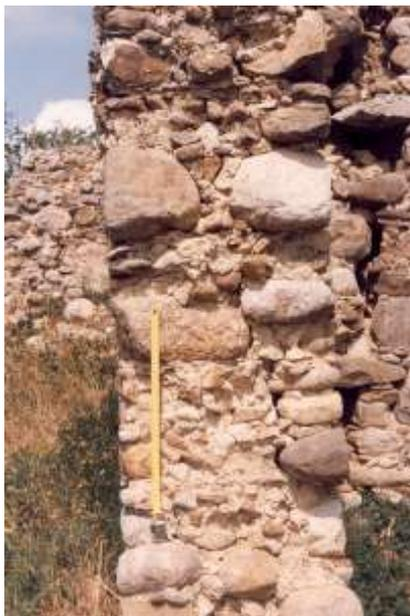
Fig. 17.2 (Aquilonia) - Tutti gli apparecchi murari campionati presentano uno scarso ammorsamento del singolo solido murario. In particolare, qui è raffigurata una muratura appartenente al primo gruppo. E' immediato verificare non solo l'assenza di *pietre passanti* ma anche il non rilevante numero di elementi lapidei oltrepassanti la metà dello spessore murario.
