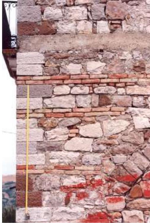
Fig. 6.2 (Aquilonia) - Particolare della fig. 5.2. L'*opera listata* consta di due file di mattoni, poste all'incirca ogni 60 cm., alternate ad elementi lapidei generalmente di forma irregolare. Solo alcuni dei blocchi utilizzati recano, specialmente in prossimità del cantonale, i piani orizzontali grossolanamente spianati.
