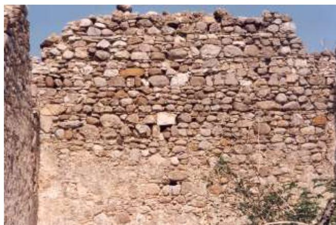
Fig. 16.2 (Aquilonia) - Ancora un caso appartenente alla prima classe tipologica. E' evidente la prevalenza dei ciottoli, sia interi che spaccati, e la presenza dei *cantieri* posti ad intervalli di circa 50-60 cm.
