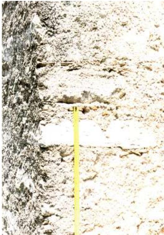
Fig. 6.1 (Senerchia) - Ancora un altro esempio di cantonale di fabbrica realizzato con blocchi sbozzati e ben *ingranati*. Esso si differenzia, però, dal caso precedente per la presenza negli allettamenti di elementi di rinzeppatura costituiti da frammenti di tegole curve.
