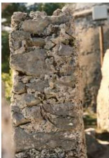
Fig. 24.3 (Pontone, Scala) - Resti della fortificazione della Rocca S. Felice. Particolare di una merlatura. Come si evince dallo foto, le pietre di maggior volume venivano, solitamente, poste di punta al paramento. E' raro, infatti, riscontrare elementi lapidei con lunghezze all'incirca pari a 30 cm., secondo un inserimento di fascia.
