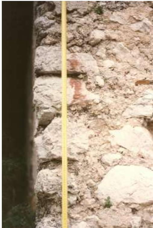
Fig. 4.1 (Senerchia) - Ancora un altro esempio di cantonale di fabbrica realizzato con elementi lapidei non differenziati dalle murature correnti. L'unica caratteristica che li distingue, infatti, dagli ordinari conci lapidei consiste nella grossolana spianatura della faccia orizzontale inferiore.
