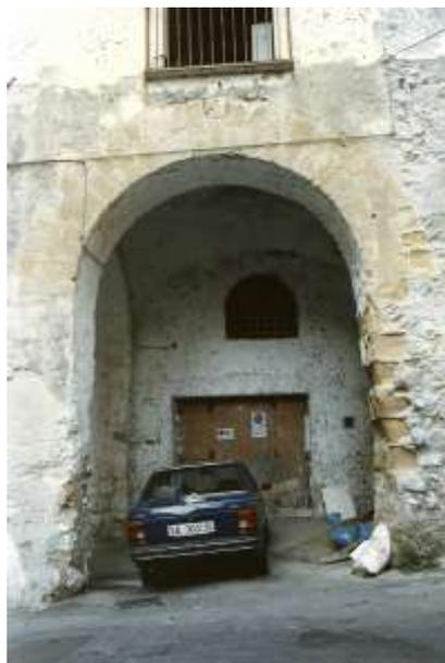
Fig. 49.3 e 50.3 (Amalfi) - Ex Cartiera Confalone. La fabbrica su via delle Cartiere, presenta un portico, girato con volte a vela, in cui sono rilevabili diversi brani murari apparecchiati per filari, con conci sbozzati di tufo giallo napoletano. La fig. 52.3 mostra il particolare dell'arco, a tutto sesto, posto sull'estremità destra del fabbricato.
