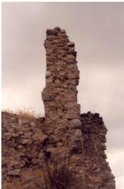
Fig. 20.2 (Aquilonia) - Apparecchio murario appartenente alla prima classe tipologica. Ancora una volta è possibile verificare la mancanza di concatenamento nel solido murario. Esso è, infatti, prevalentemente costituito da elementi lapidei di non adeguata consistenza che, anche se posti di punta e sovrapposti, sono insufficienti a realizzare un buon ingranamento.
