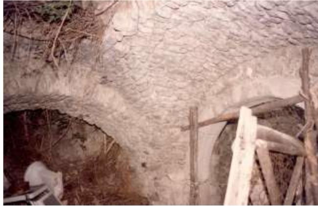
Fig. 45.2 (Aquilonia) - In questo caso, la volta a vela mostra un apparecchio di ciottolo ortogonalmente alle diagonali della pianta. E' inoltre, visibile sulla destra della foto un sott'arco realizzato per il consolidamento del vano voltato.
