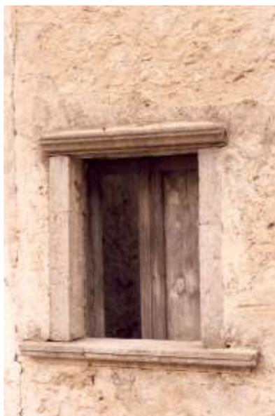
Fig. 50.2 (Aquilonia) - Fronte posteriore dell'edificio raffigurato nella foto 49.2. Sono da evidenziare due interessanti singolarità; la prima è costituita dall'architrave rappresentato, con tutta evidenza, da un elemento lapideo di reimpiego. L'altra, più interessante, riguarda il davanzale. Esso non è costituito, come avviene tradizionalmente, da un unico blocco lapideo ma
