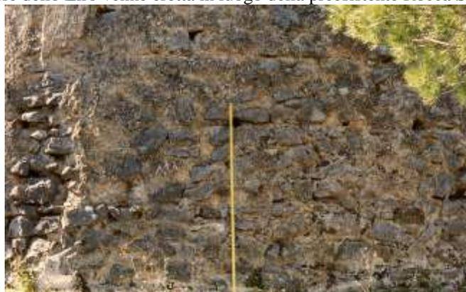
Fig. 29.3 (Amalfi) - La *Torre dello Ziro*. Parete sud-orientale. E' immediato verificare l'esistenza dei cantieri. Essi, di altezza non proprio costante, sono presenti omogeneamente, per quanto ne sia possibile la verifica, nell'intera base tronco-conica della fabbrica.
