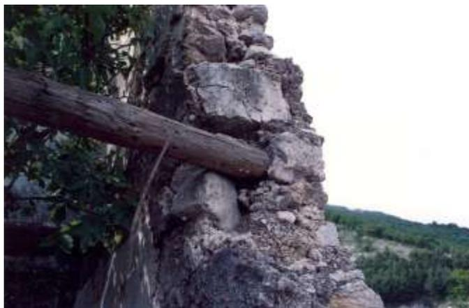
Fig. 48.1 (Senerchia) - I tradizionali solai lignei sono realizzati con un'orditura semplice di travi grezze di castagno. A sostenere il sovrastante massetto era posto in opera un assito di tavole sempre di legno castagno.
