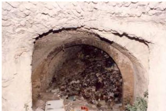
Fig. 47.2 (Aquilonia) - Un altro esempio di rafforzamento di un vano voltato ottenuto attraverso la realizzazione di un arco in pietra locale e laterizio.
