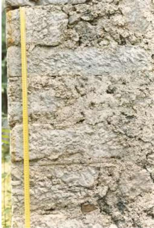
Fig. 5.1 (Senerchia) - E' qui raffigurato un cantonale di fattura più complessa rispetto agli esempi precedenti. E' immediato verificare infatti, che gli elementi lapidei non solo sono ben squadretti ma anche accuratamente *ingranati*. Essi sono, difatti, inseriti alternatamente di fascia e di punta garantendo, così, un efficace concatenamento dello spigolo murario.
