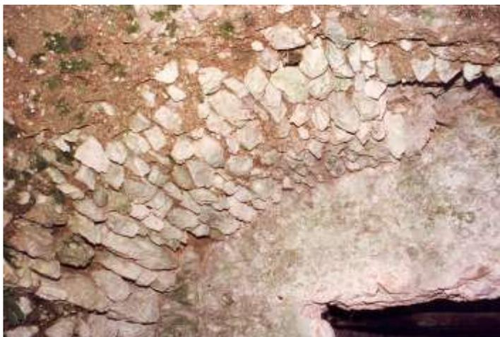
Fig. 40.1 (Senerchia) - Un altro esemplare di struttura voltata. Pur presentando un'analogia tecnica, l'apparecchio di questa piccola volta a botte si mostra, rispetto al caso precedente, senz'altro di fattura meno accurata per l'utilizzo più frequente di elementi lapidei di piccolo volume ed il conseguente uso più abbondante di malta.
