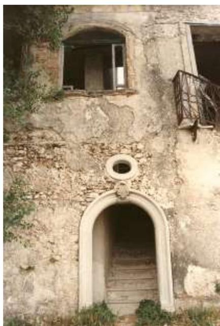
Fig. 9.1 (Senerchia) - Ancora un altro esempio di bucatore realizzate con moderni laterizi.
