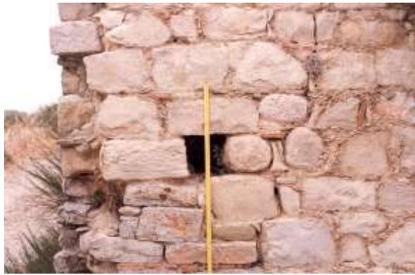
Fig. 31.2 (Aquilonia) - Piuttosto rari sono i casi in cui, unitamente al tradizionale materiale calcareo ed arenario, viene utilizzato anche il tufo. Laddove ciò si verifica, naturalmente, la migliore lavorabilità del materiale in oggetto influisce anche sulla tessitura muraria che viene ad essere più regolare.
