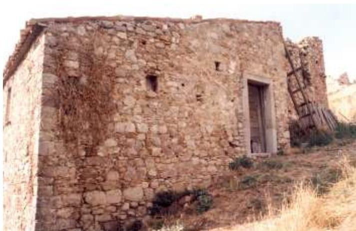
Figg. 33.2 e 34.2 (Aquilonia) - Esempi di cantonali di fabbrica realizzati con elementi lapidei gerarchizzati.
