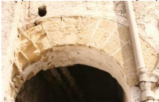
Fig. 47.3 (Amalfi) - Salita S. Lorenzo, n. 21. L'arco, in ciò differenziandosi dalla locale tradizione costruttiva, è costituito da un doppio ordine di conci cuneiformi - perfettamente sbozzati - di tufo giallo napoletano.
