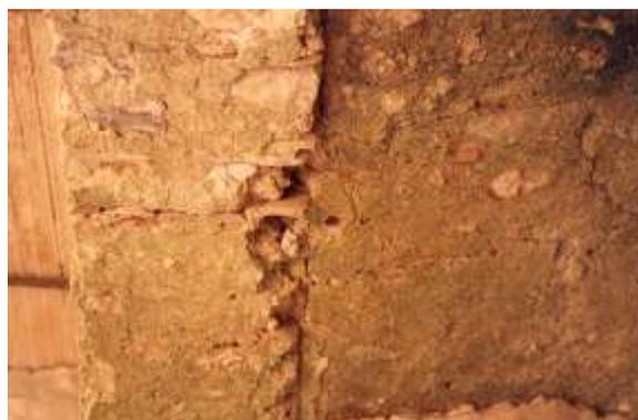
Fig. 39.1 (Senerchia Palazzo Cuozzo) Particolare della volta a vela che ricopre la porzione occidentale del vestibolo. Anche per gli apparecchi delle volte venivano utilizzati le *pietre rustiche* nella locale varietà calcarea inserite, preferibilmente, perpendicolarmente alla superficie d'intradosso. Ad esse vengono, in questo caso, alternate una o due
