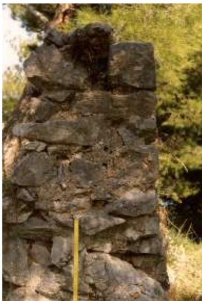
Fig. 36.3 (Pontone, Scala) - Castrum Scalelle. Particolare dello spessore del muro di fig. 32.3. Si noti l'efficace ingranamento realizzato tra i conci che, pur non prevedendo l'utilizzo di *pietre passanti*, vede comunque i blocchi più grandi alternativamente posti di punta e di fascia.
