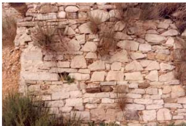
Fig. 29.2 (Aquilonia) - Sottotipo B della seconda classe. Si è ritenuto opportuno distinguere l'apparecchio in esame perché, pur se all'interno dei parametri che connotano la seconda classe, è qui evidente una minore diffusione di elementi lapidei sbozzati a fronte, viceversa, di un maggior numero di pietre rustiche. Oltre a ciò, in questo particolare caso le assisi di ripianamento, anche quando limitate ai soli cantieri, risultano molto più irregolari se non talvolta del tutto assenti.
