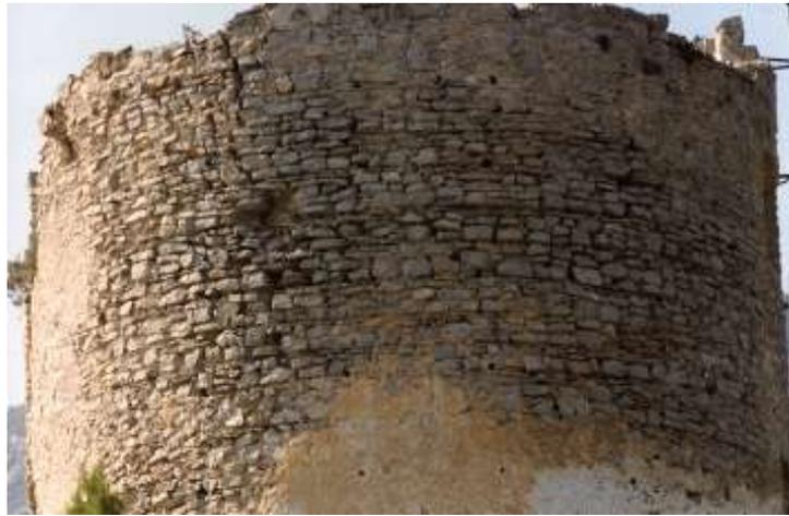
Fig. 31.3 (Amalfi) - La Torre dello Ziro. Particolare del corpo cilindrico superiore. Fronte sud-orientale. Sono evidenti i cantieri e la discreta diffusione di elementi lapidei, di adeguata consistenza, sbozzati almeno sui piani orizzontali.
