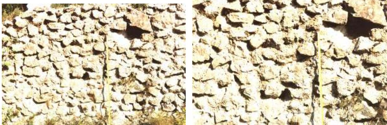
Fig. 26.3 e 27.3 (Pontone, Scala) - Castrum Scalelle. Anche questo campione - appartenente ad una delle tre vasche in muratura site nelle vicinanze del castrum - non sembra essere stato apparecchiato secondo una disposizione a cantieri. L'unico orizzontamento, piuttosto irregolare, che si rileva è posto a circa 60 cm. da terra.
