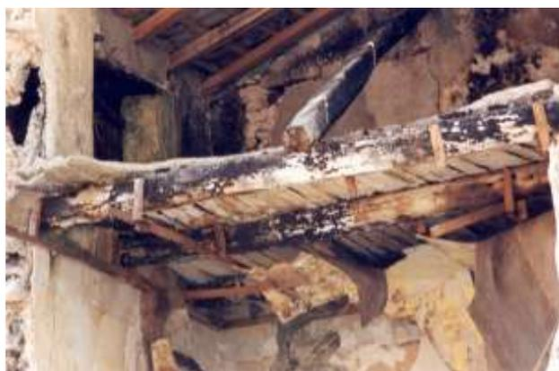
Fig. 51.1 e 52.1 (Senerchia) - Solai, sempre ad orditura semplice, realizzati con travi grossolanamente squadrate di legno castagno.
