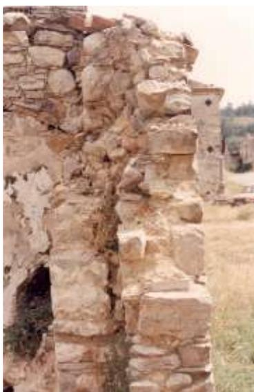
Fig. 24.2 (Aquilonia) - Gli elementi lapidei sbozzati utilizzati nelle murature della seconda classe sono inseriti tanto di fascia che di punta. In particolare, qui è possibile verificare che la spianatura delle facce orizzontali del concio può anche avvenire per la loro intera estensione.
