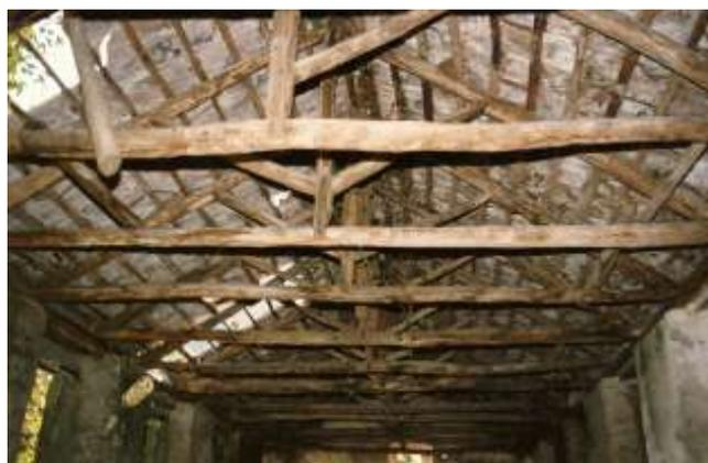
Fig. 42.3 (Amalfi) - Valle dei Mulini. Cartiera Marino. La copertura a doppia falda ivi raffigurata è realizzata mediante tredici capriate. Esse, in legno castagno grezzo, sono composte da: catena, puntoni, monaco, raggi, arcarecci e *cassa*, sempre in travi grezze di castagno. L'attuale manto è di recente confezione essendo costituito da tegole marsigliesi.
