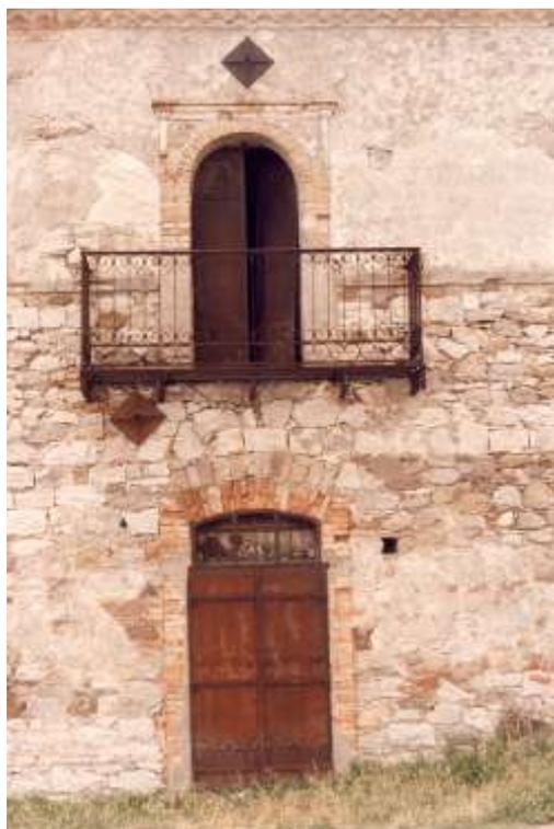
Fig. 4.2 (Aquilonia) - Edificio sito in largo Croce. Anche in questo caso le bucatore sono state costruite in mattoni correnti. In particolare, l'ingresso mostra l'impiego di *doppi archi*, molto ribassati, il primo in pietra locale ed il secondo in laterizio. Per quanto concerne l'apertura superiore essa, simmetricamente alla bucatura posta sulla destra, era in origine una finestra poi trasformata con l'inserimento di un oggetto a struttura metallica.
