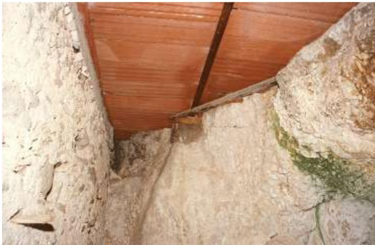
Fig. 2.1 (Senerchia) - Un altro esemplare delle suddette cavità ove, però, il tradizionale solaio ligneo posto a copertura del terraneo è stato sostituito con putrelle e tavelle in laterizio.
