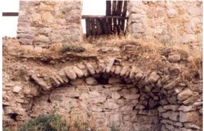
Figg. 43.2 e 44.2 (Aquilonia) - Particolari di volte a botte con sesto ribassato sempre realizzato con ciottoli ed, in minor misura, pietre rustiche inseriti di punta.
