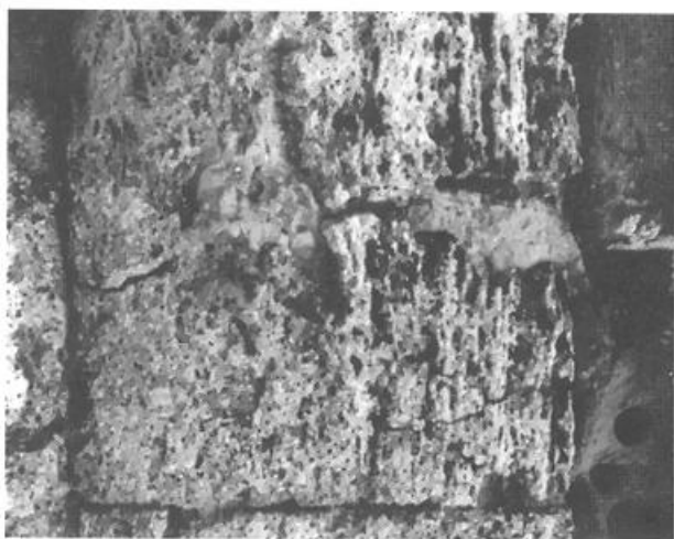
Fig. 2. Tempio di Cerere, sigillature a cemento del frontone eseguite nel restauro anni '60.
