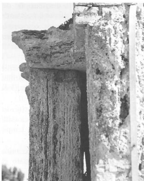
Fig. 10. Foto del filare realizzato con doppio spessore di travertino; la lastra interna di piccolo spessore è disposta con giacitura verticale.
