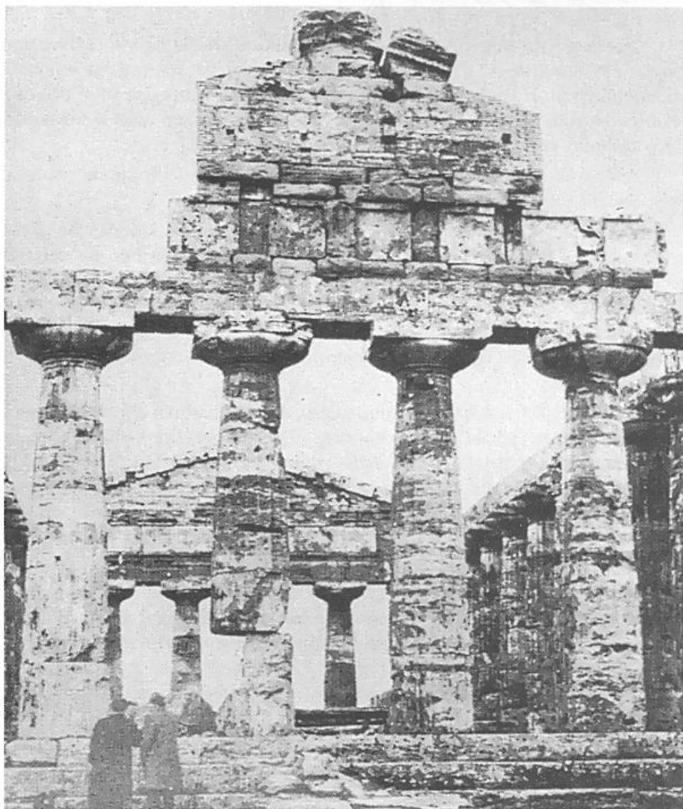
Fig. 6. Effetto del fulmine sul monumento : foto n° 10682 della Soprintendenza Archeologica di Salerno (pubblicata anche da F. Lizzi nel volume citato). La scarica elettrica fu condotta dentro lo spessore della colonna dalle armature verticali che scendono fino al penultimo rocchio ; alla interruzione del conduttore si verificò l'effetto dirompende.
