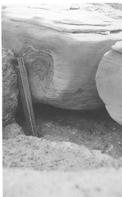
Fig. 15. Lacune tra le pietre che comportano difetto nelle superfici di appoggio e riducono la resistenza al ribaltamento. Solo questo tipo di lacune richiede una risarcitura resistente.
