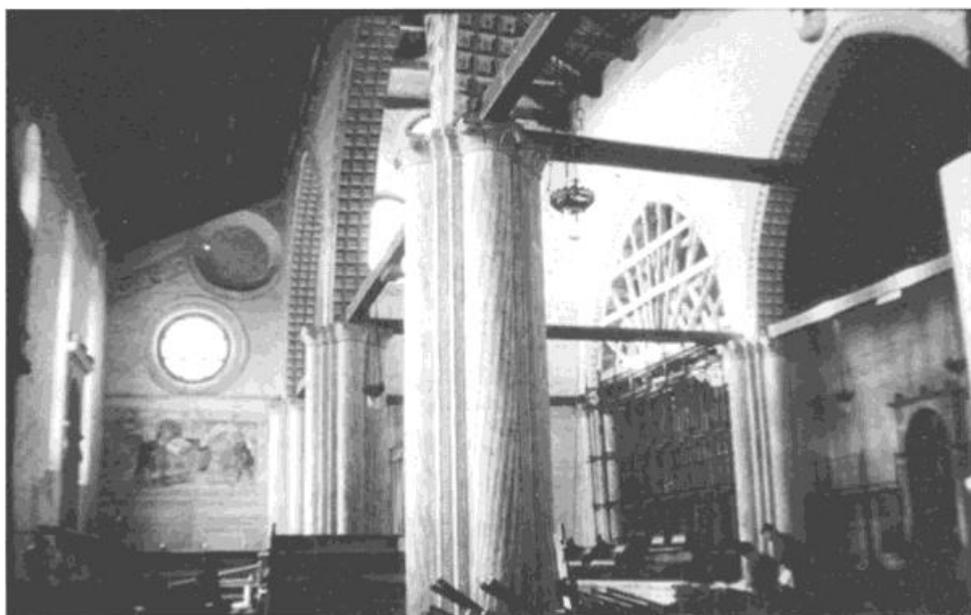
*Foto n. 17. Duomo di Spilimbergo : centinatura della l'arcata laterale sinistra in corrispondenza del puntello esterno.*
