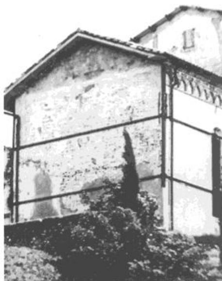
Foto n. 4. Tirantatura di un corpo di fabbrica le cui murature sono soggette a ruotare verso l'esterno.
