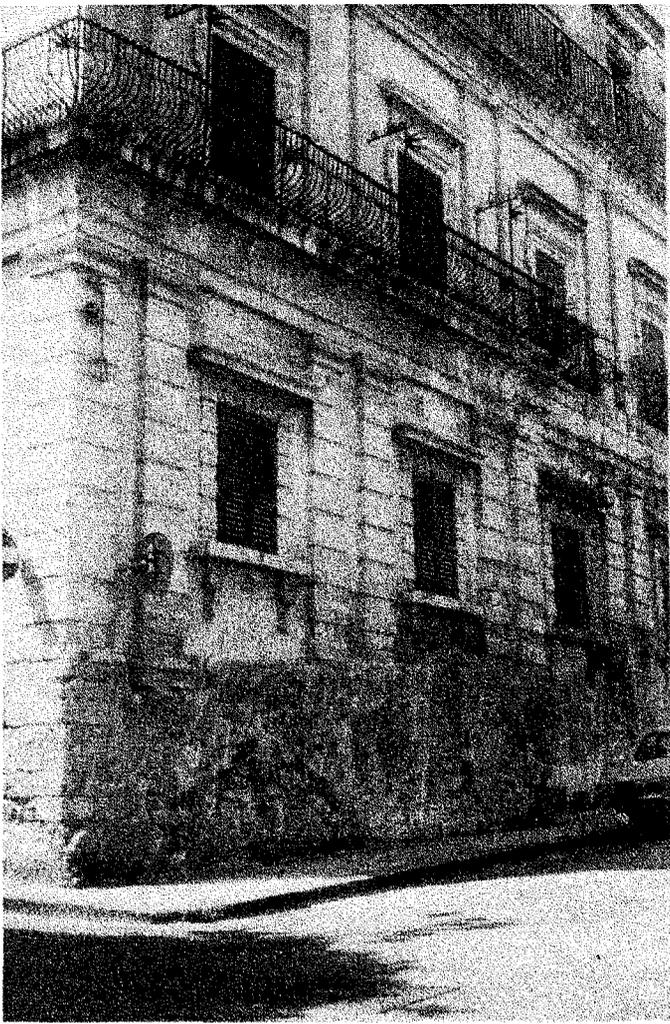
Fig.8 - 9 - Dans cet édifice de Noto le nouvel abaissement du niveau de la route, opéré en dix-neuvième siècle, a montré ses fondations.
