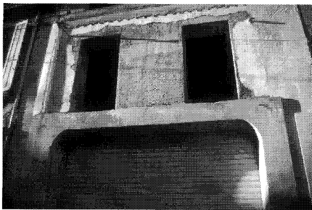
Création d'ouvertures pour le passage de véhicules
