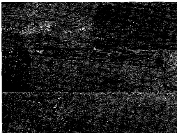
Lámina 2. Santa María de Eunate de Valdizarbe. A: sillar de microconglomerado poligénico mioceno. B: columna de arenisca miocena con laminación cruzada e intensos procesos de alveolización. C: sillar con una laminación oblicua que separa la arenisca basal de la arenisca suprayacente con cantos blandos. D: fotografía vertical del arco triunfal donde se aprecian las diferentes tonalidades de las areniscas miocenas y los ángulos entre los nervios del ábside.
