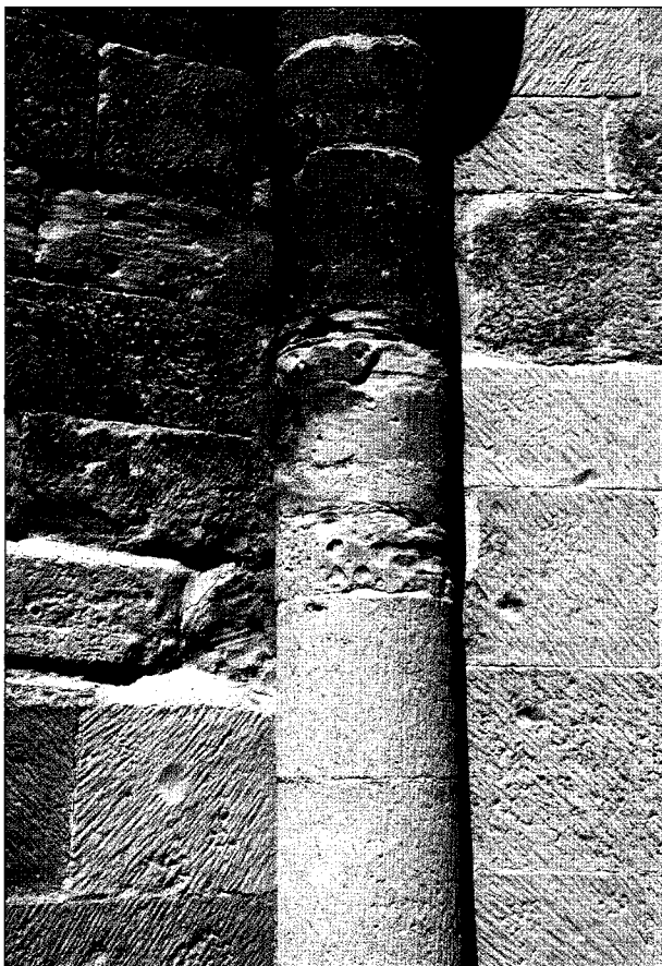
7. - Paramento de la iglesia de Torres del Río (Navarra), donde son evidentes las restauraciones realizadas en los años sesenta.
