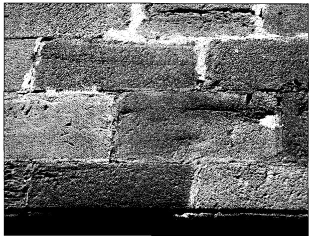
11. - Detalle de la técnica constructiva empleada en la realización de la iglesia de Santa María de Eunate (Navarra) en su segunda etapa, en la que son evidentes las marcas del tallante utilizado en la talla de los sillares.
