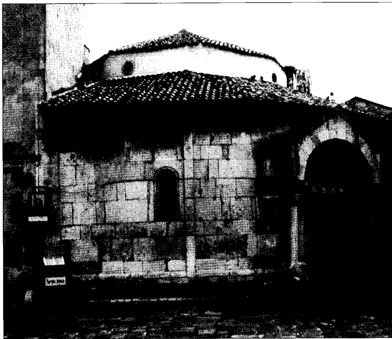
4. - Chiesa di San Giovanni al Sepolcro a Brindisi: vista dell'esterno. Il tozzo protiro, impostato su protomi leonine, si innesta nella regolare muratura pseudoisodoma della rotonda.
