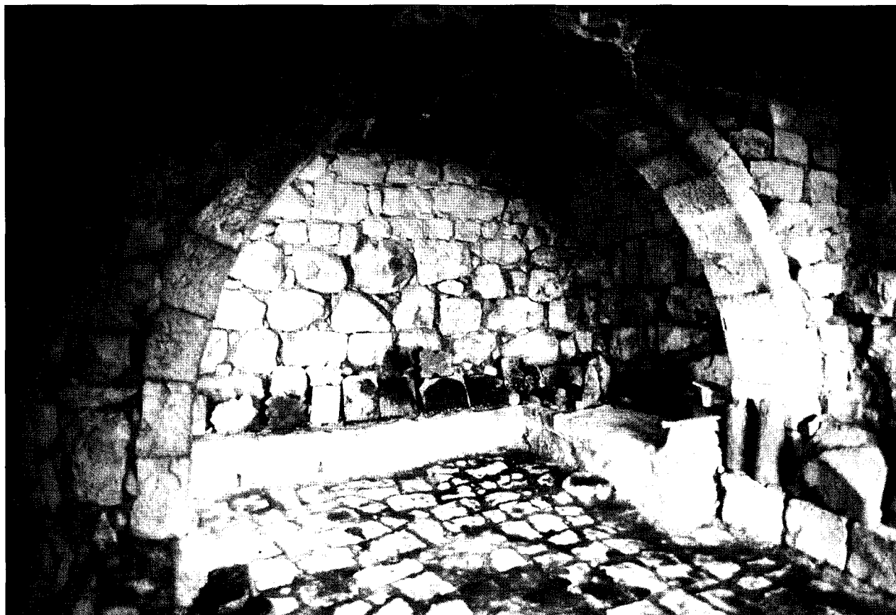
4. - Al-Azraq (Giordania), interno con archi a ogiva che sostengono trabeazioni basaltiche.
